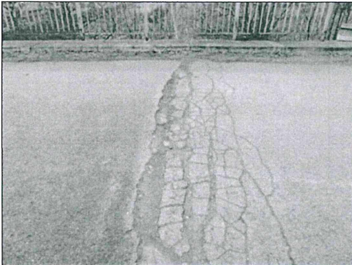
Oblast mostního závěru -konec mostu.
