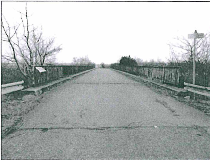
Pohled na mostní objekt proti směru zvoleného staničení.
