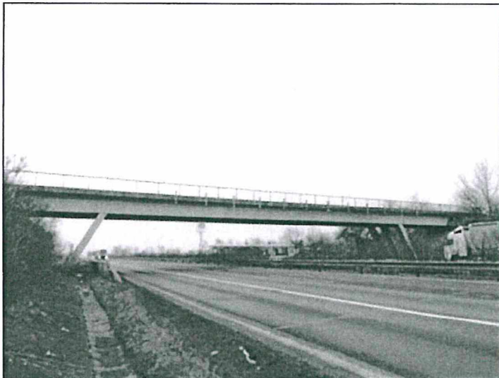
Pohled na most z pravé strany -směr Praha.
