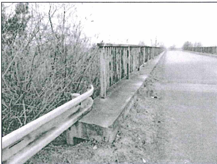
Závada v napojení svodidla.
