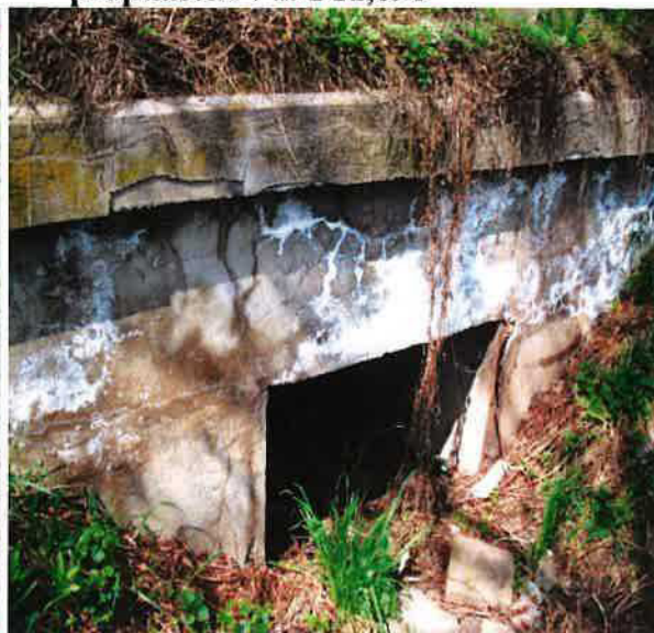
propuastek v km 11,090
