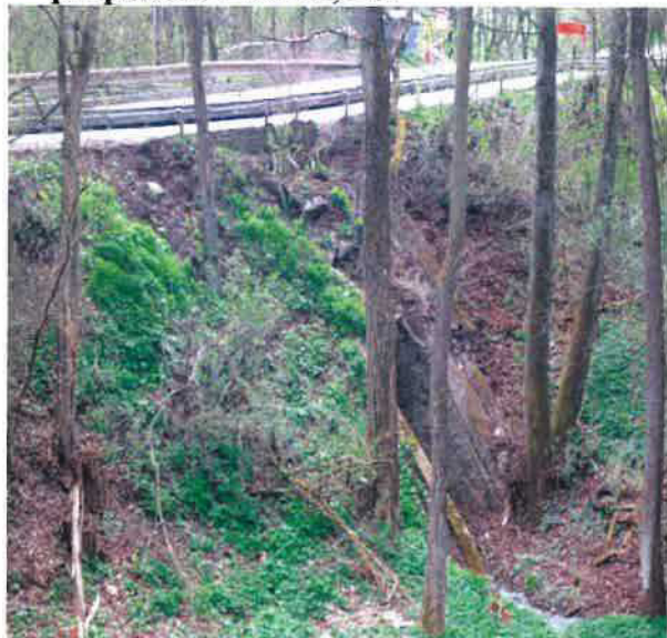
propustek v km 10,570
