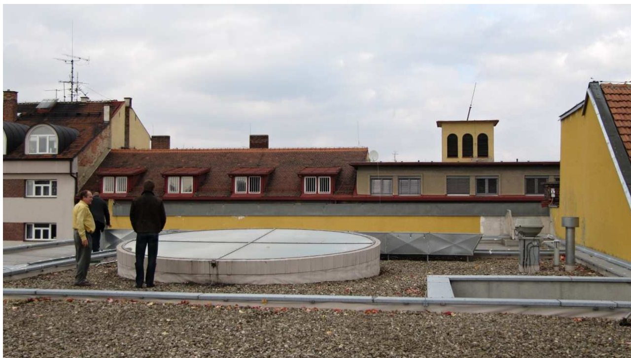
Obr. 4: Pohled z objektu F na objekt na ulici Jiráskově
