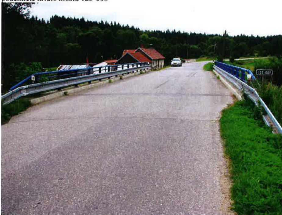
pohled na most ev.č. 125-009
