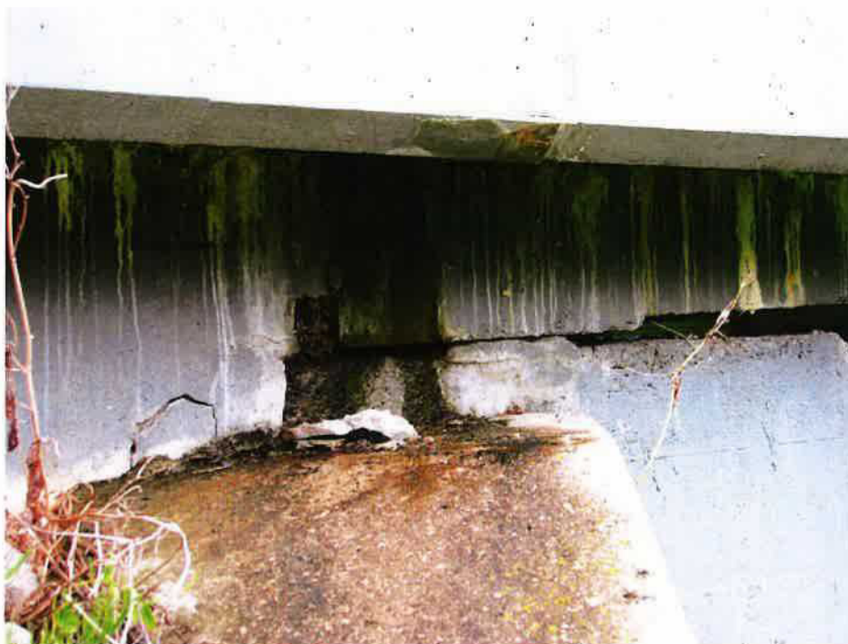
pohled na úložný práh 125-009
