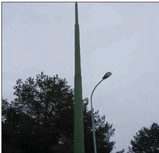
Foto č.1 – pohled na oddálený bleskosvod (výška 14 m)
