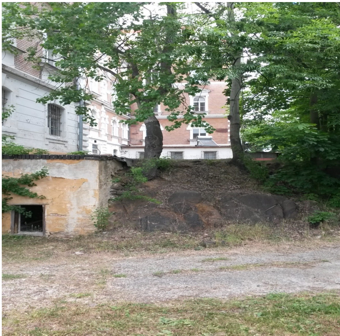
V 07: Úprava pozemku a výsadba u fasády B3-C1 – stávající stav přístavba k budově
