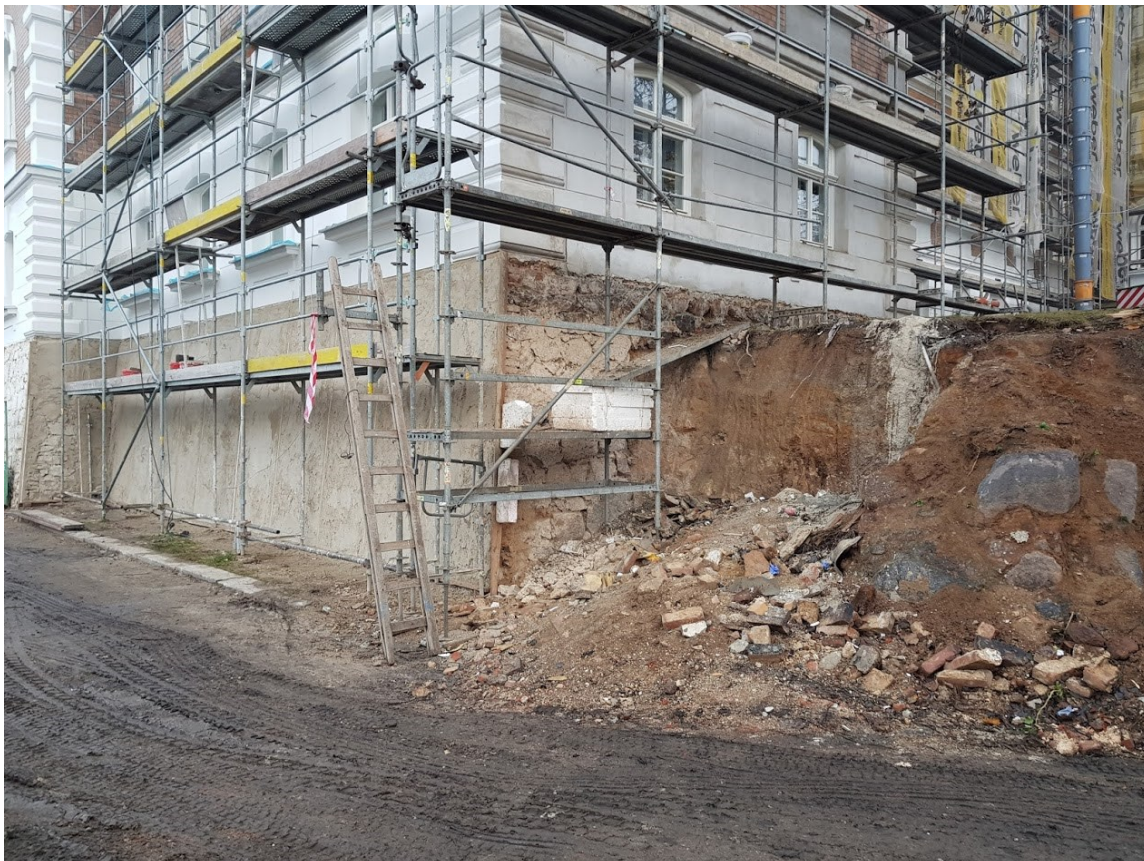
V 07: demolice přístavku
