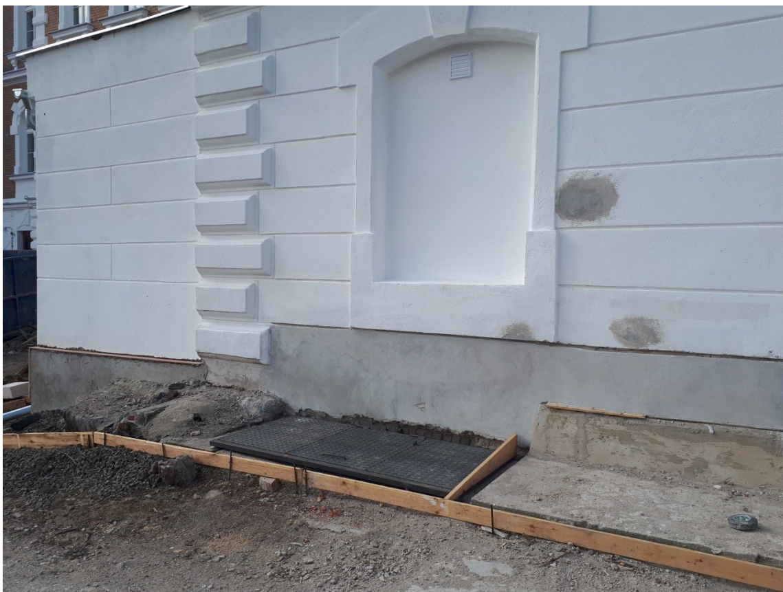
V 02: Provedení odvětrání WC tělocvičny na fasádu
