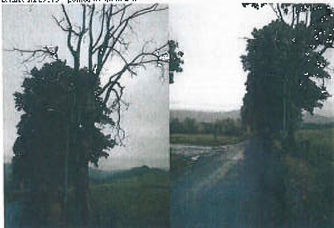
Sítlice III/29015 – pohled na strom č. 6
