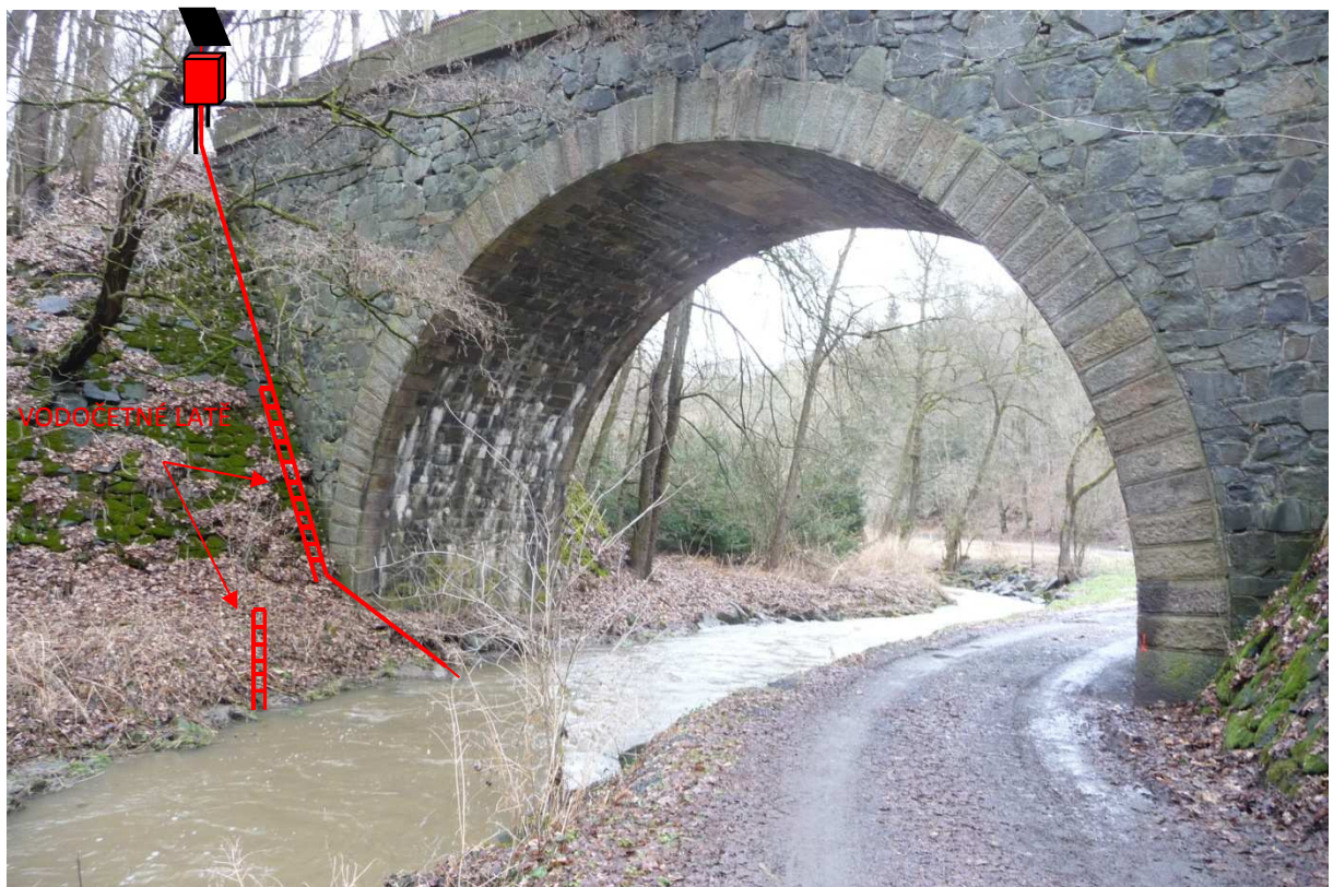
Obrázek 8 – Pohled na schematické umístění telemetrické stanice, tlakové sondy a vodočetných latí
