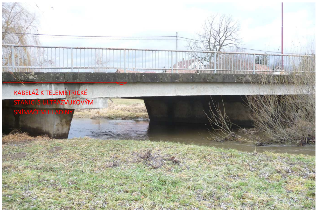
Obrázek 5 – Umístění ultrazvukového snímače hladiny na mostní konstrukci
