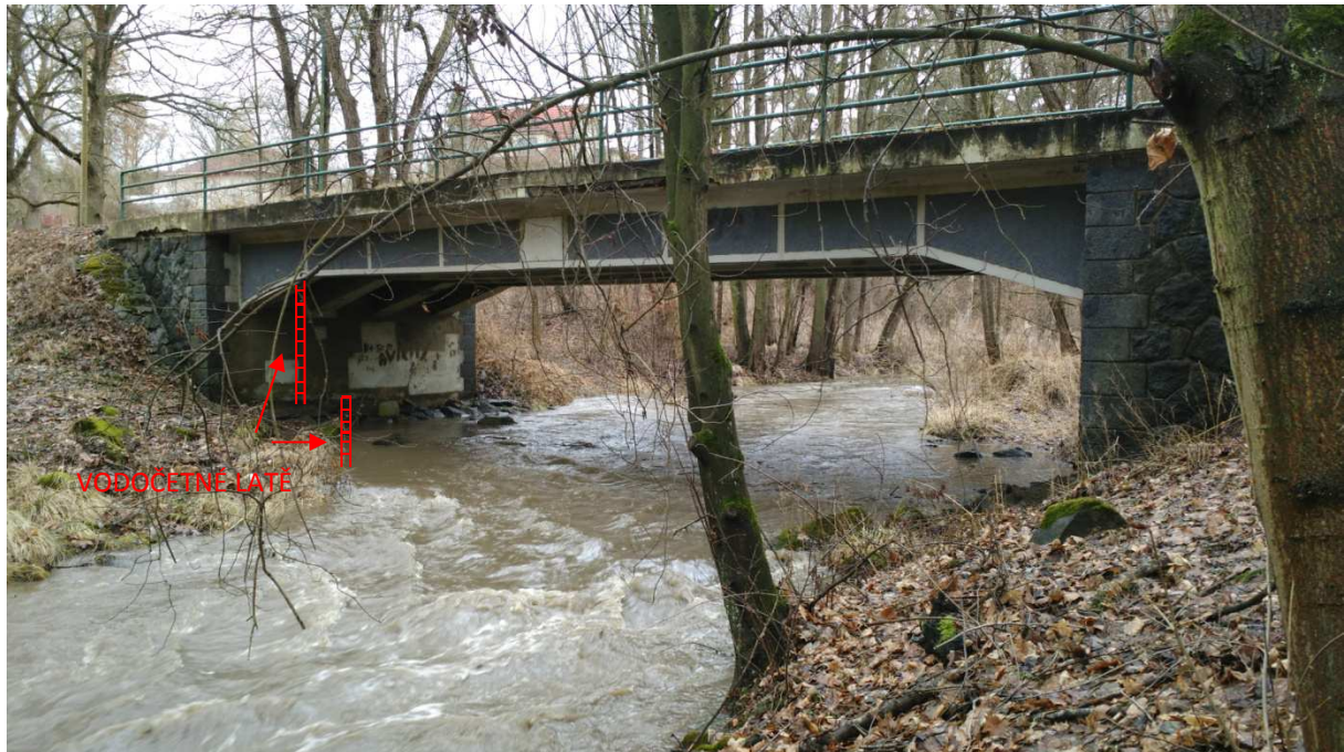
Obrázek 1 - Situační schéma umístění vodočetných latí – mimo mostní objekt pro sledování nižších stavů, na mostním objektu pro vyšší průtokové stavy (pohled proti proudu)
