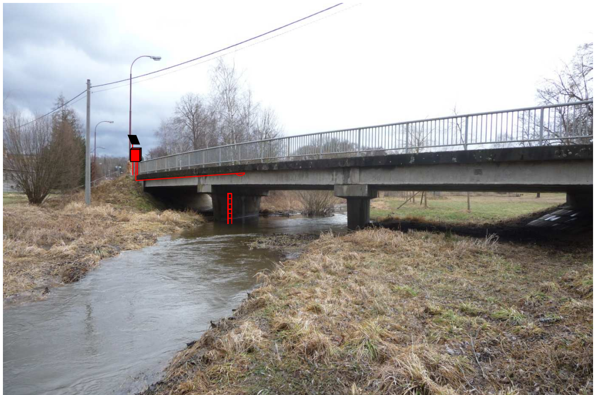
Obrázek 4 - Pohled na lokalitu se schematickým umístěním hladinoměru, telemetrické stanice a vodočetné lati na mostní konstrukci
