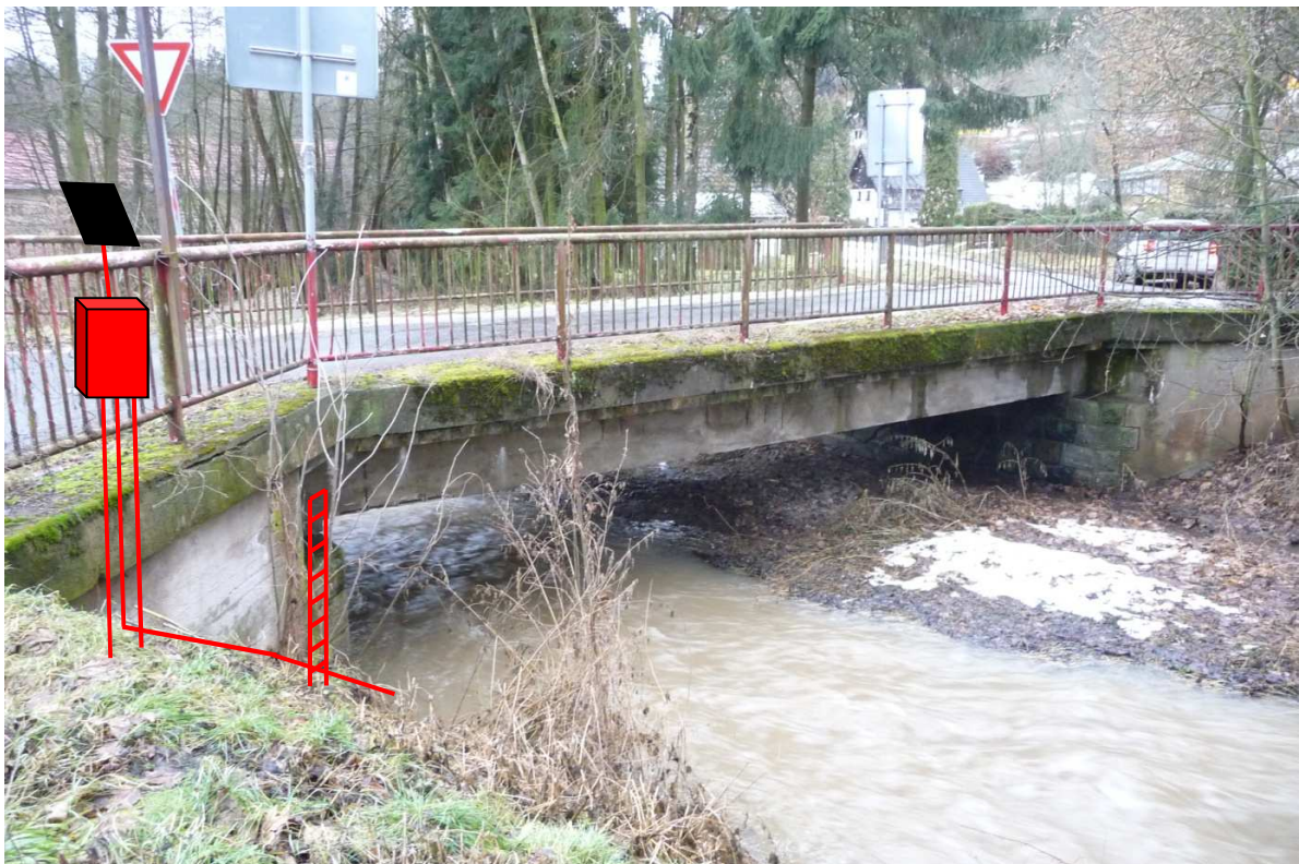
Obrázek 14 – Pohled na celý objekt mostu se schematickým umístěním měrné stanice
