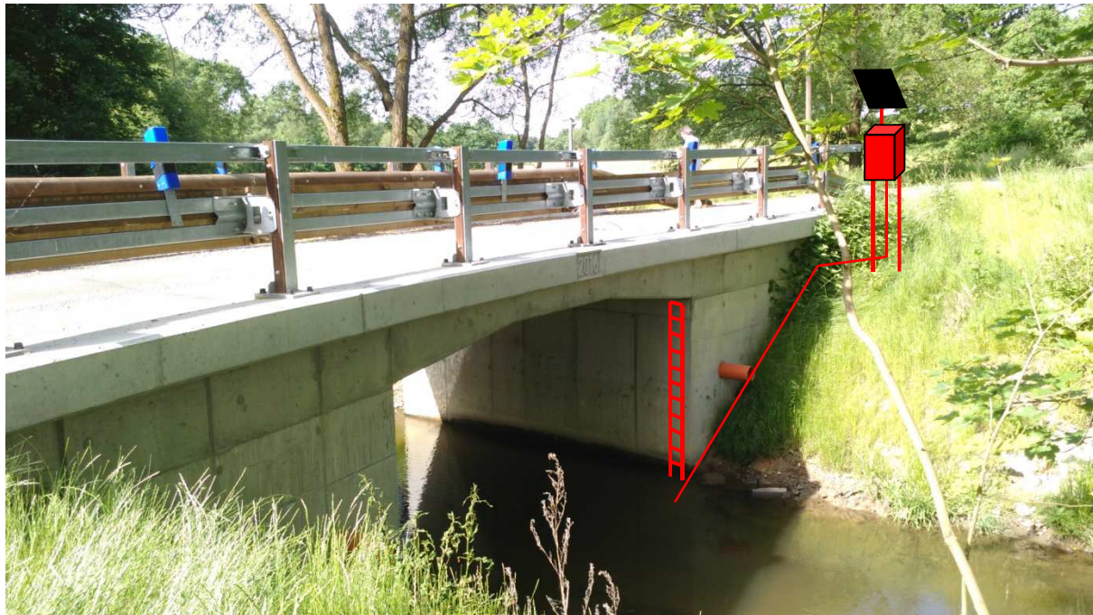
Obrázek 18 - Pohled na schematické umístění telemetrické stanice, tlakové sondy a vodočetné latě
