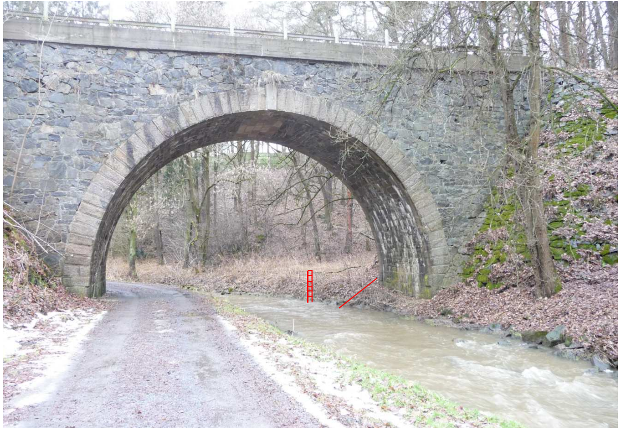
Obrázek 7 - Pohled na most z návodní strany a schematické umístění vodočetné latě pro odečítání nižších vodních stavů a tlakové sondy
