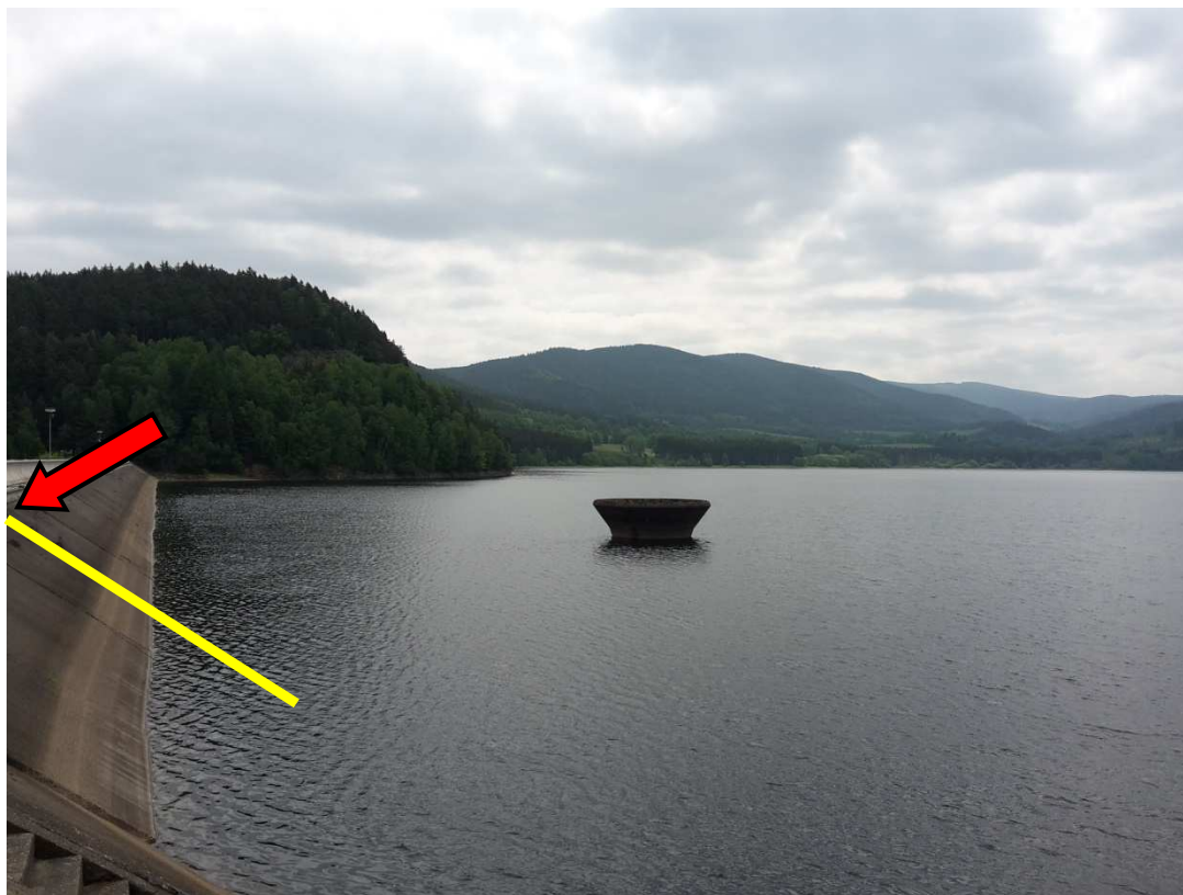
Obrázek 2 - Pohled na návodní líc hráze VD Nýrsko (červeně - umístění stanice na vlnolamu, žlutě - chránička sondy)
