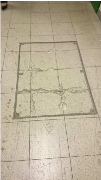
Foto 03: Poklop u vstupu do objektu A13 – nášlapná vrstva dlažba.
