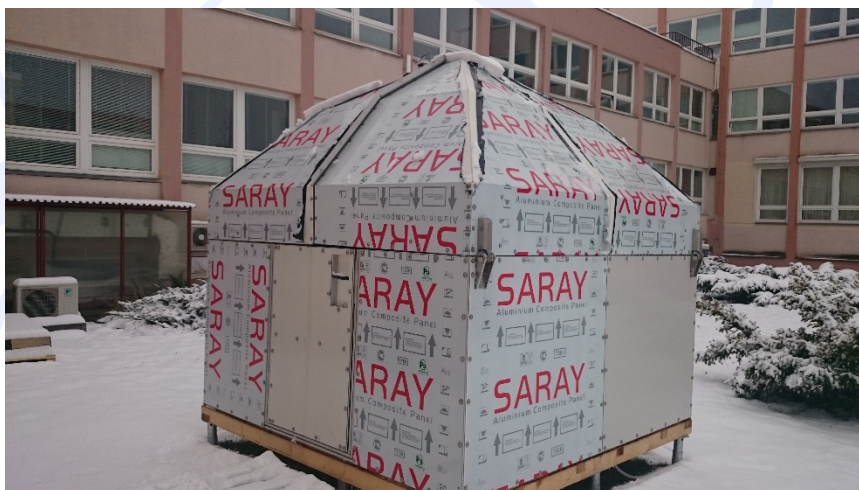
1: Příklad realizace kupole robotického dalekohledu
