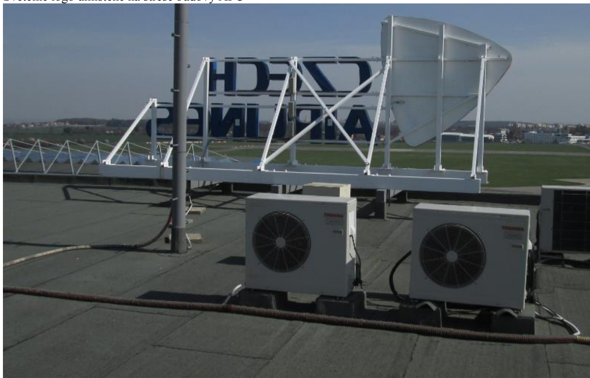
Světelné logo umístěné na střeše budovy APC
