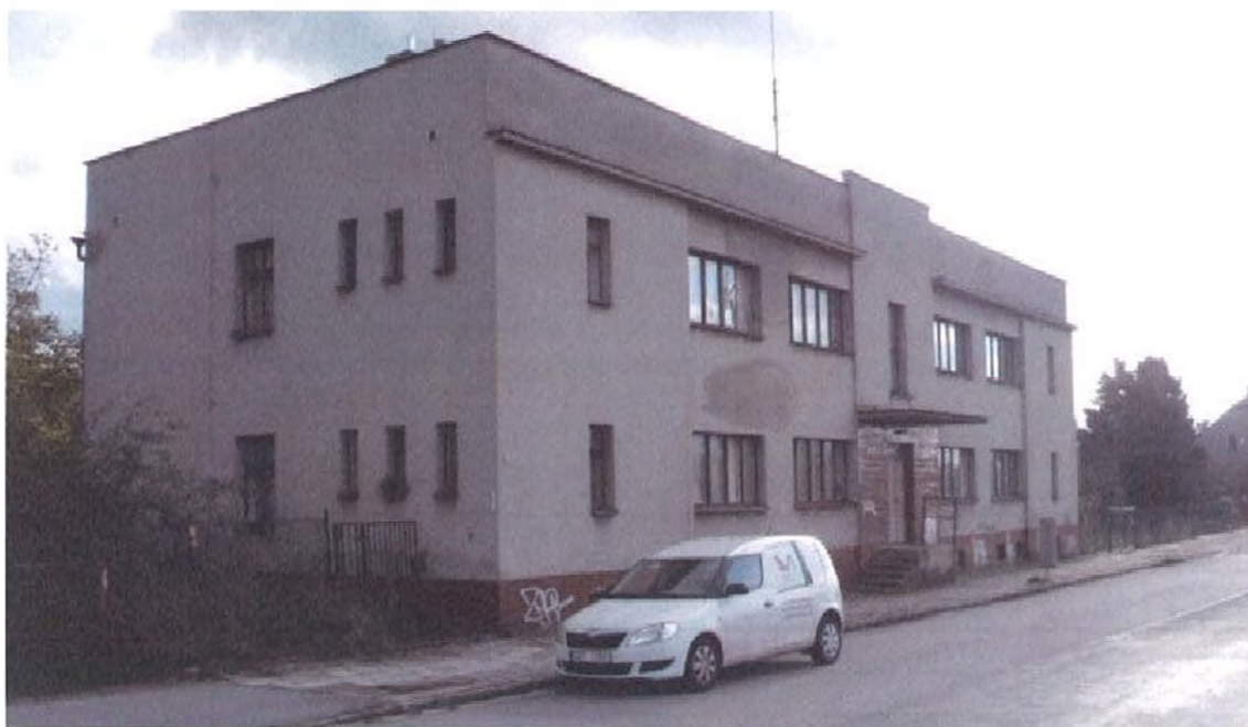
stávající budova určená k demolici
