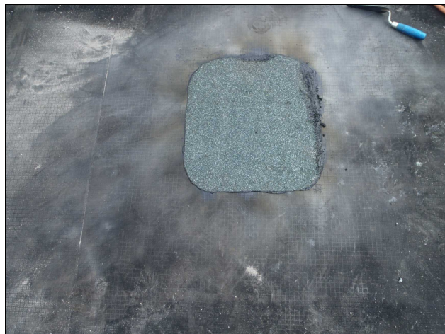
foto /8/ Sonda S4 po zapravení
