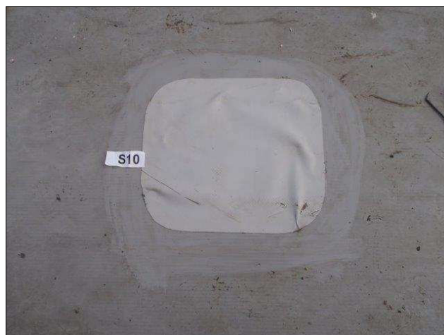
foto /20/ Sonda S10 po zapravení
