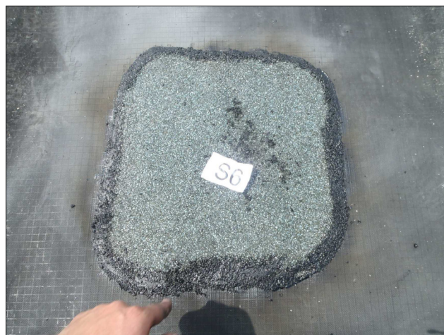
foto /12/ Sonda S6 po zapravení
