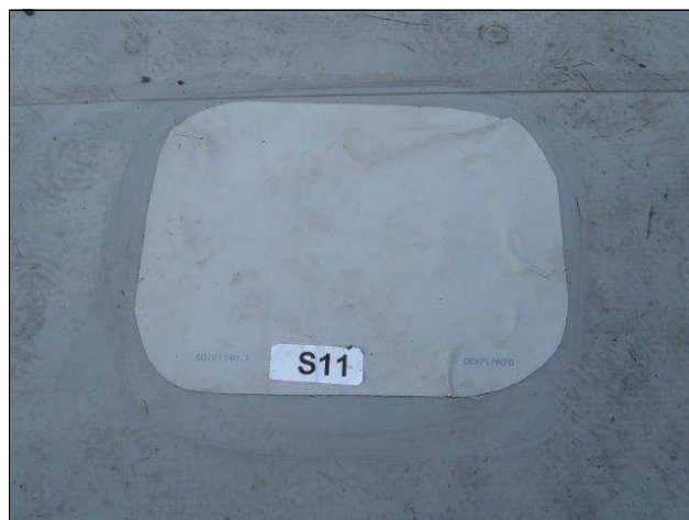
foto /22/ Sonda S11 po zapravení
