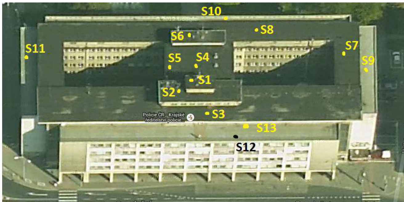
Obr. /1/ Pohled na objekt s vyznačením míst provedení sond
