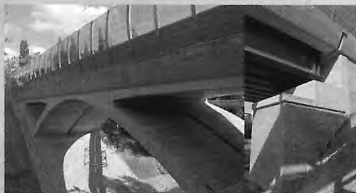
Průjezd uzel Plzeň ve směru III - železniční uzel Plzeň
