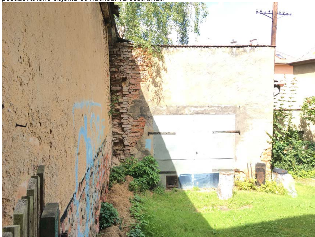
Obr. 2 – Pohled na zadní část objektu s přistavěnou garáží na sousedním pozemku, je patrná subtilní atika nad střechou, která je patrně pokračováním dělicí nenosné přízdívky, mezi ní a stěnou posuzovaného objektu se nachází vzrostlá bříza
