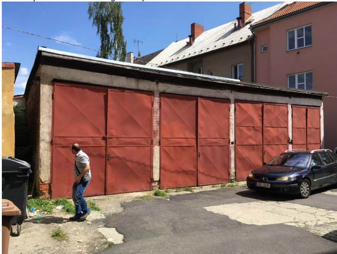
Obr. 2 – Pohled na zadní část objektu s přistavěnou garáží na sousedním pozemku, je patrná subtilní atika nad střechou, která je patrně pokračováním dělicí nenosné přízdívky, mezi ní a stěnou posuzovaného objektu se nachází vzrostlá bříza
