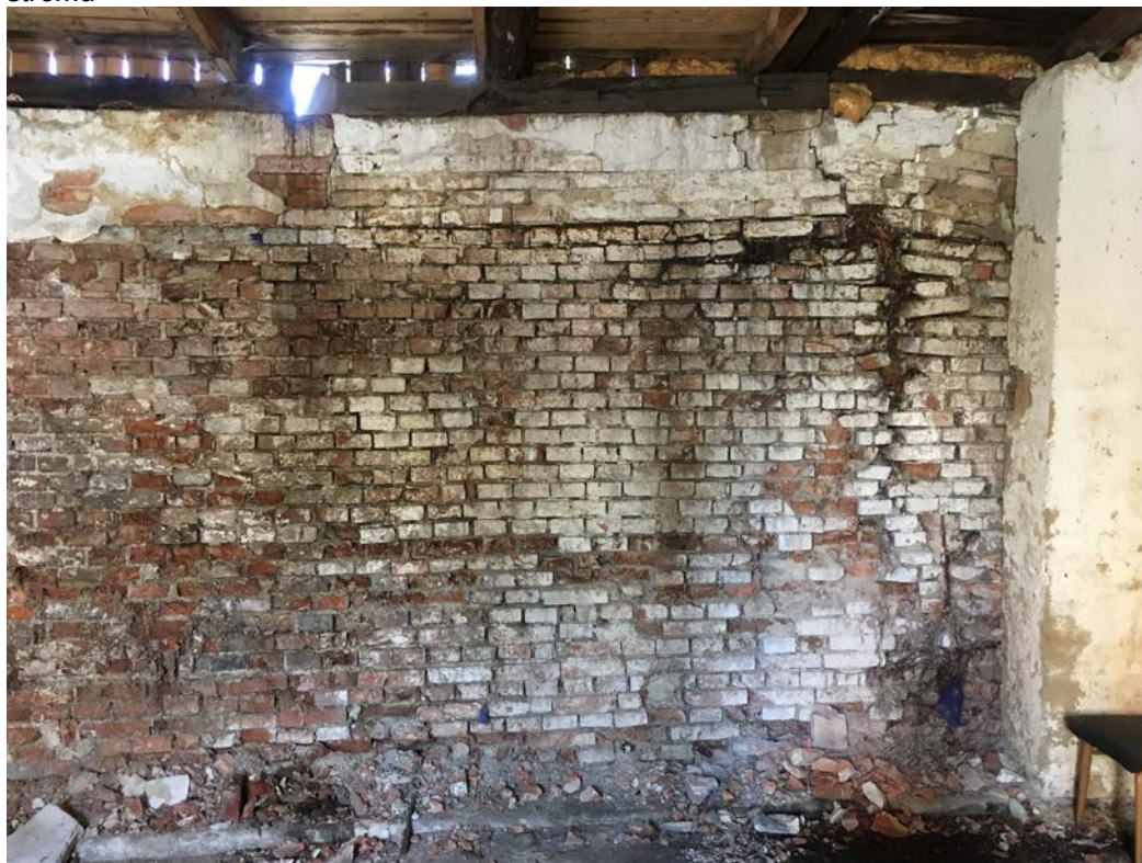
Obr. 4 – Pohled na štítovou stěnu porušenou prasklinou v důsledku pohybu základové spáry
