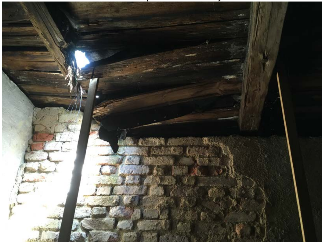
Obr. 5 – Pohled do interiéru garáže, je patrné napadení téměř všech dřevěných prvků dřevokaznými houbami
