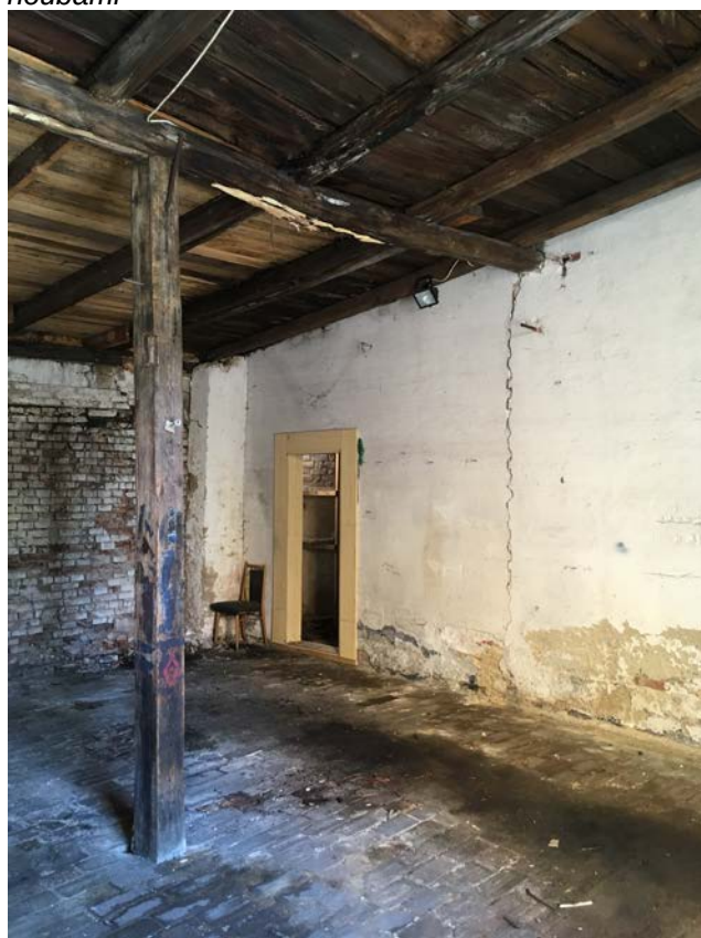
Obr. 5 – Pohled do interiéru garáže, je patrné napadení téměř všech dřevěných prvků dřevokaznými houbami
