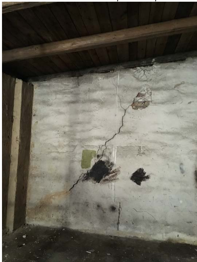
Obr. 4 – Pohled na štítovou stěnu porušenou prasklinou v důsledku pohybu základové spáry
