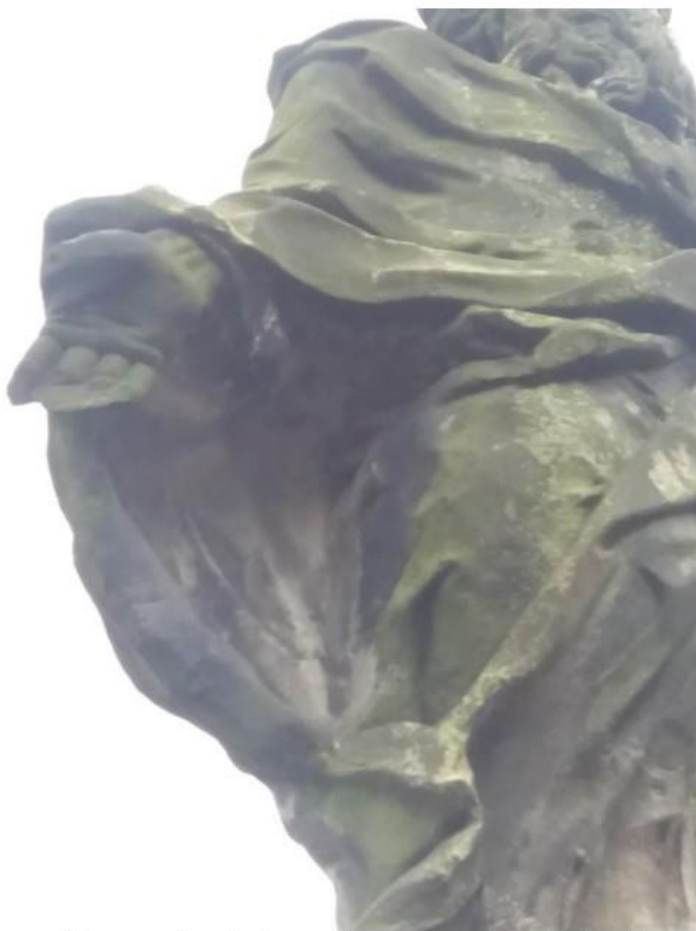
Socha sv. Petra, současný stav poškození korozí a nálety mikrovegetace, drobné destrukce pravé ruky.
