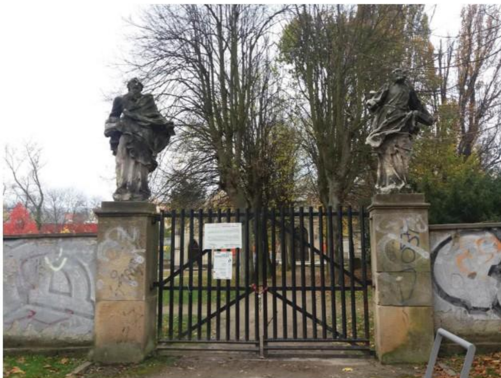
Sochy sv. Petra a Pavla na pilířích brány , stávající stav, pilíře poškozené nástřiky vandalů, říjen 2017
