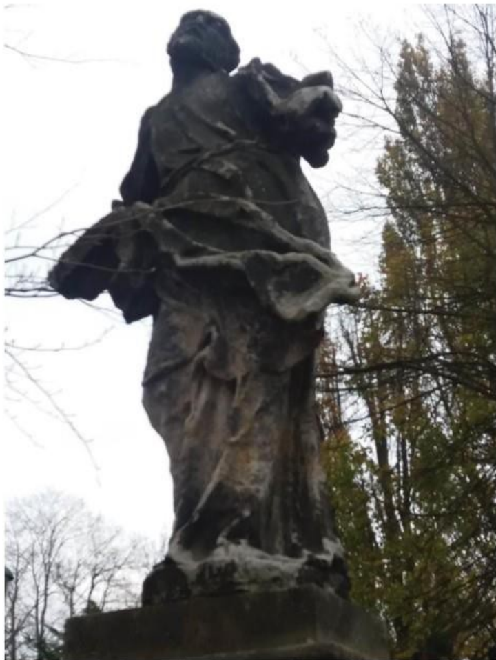
Socha sv. Pavla, současný stav poškození korozi a nálety mikrovegetace, drobné destrukce
