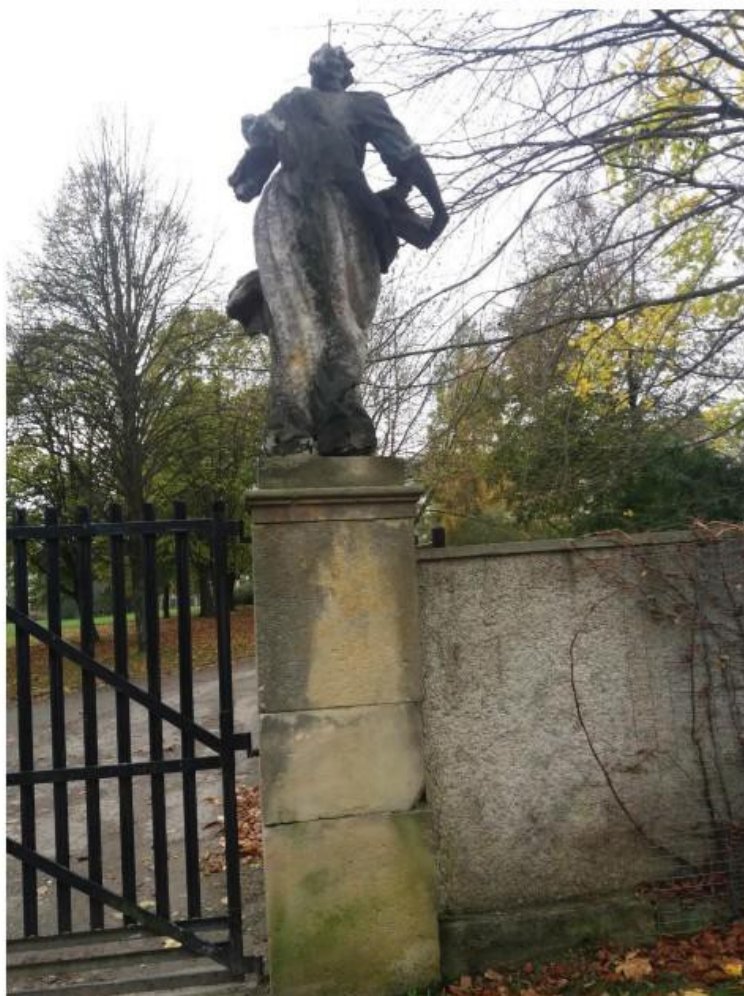
Socha sv Pavla, současný stav poškození korozí a nálety mikrovegetace, drobné destrukce, hloubková koroze levé části, tzv. důlková koroze.
