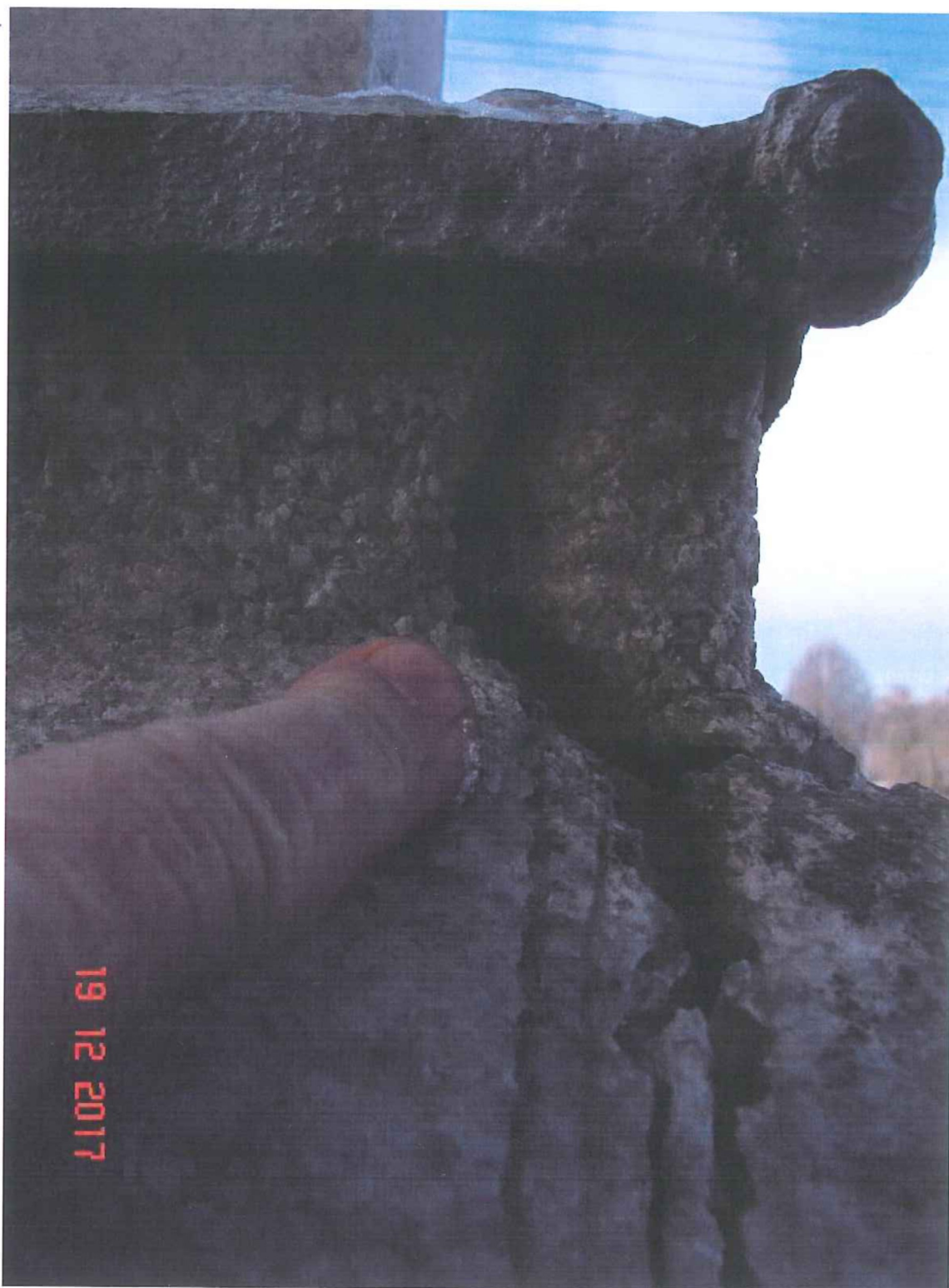
foto č. 4 kříž u kaple v Ráječku detail poškození pohled před restaurováním
