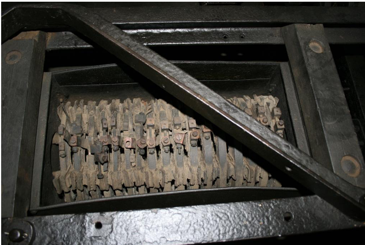
inv. č. 279 podvozek motorového vozu č. 7 Křižíkovy elektrické dráhy - kontrolér
