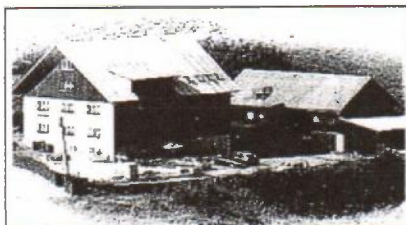
CHATA HRÁDEK Energetika Třinec
