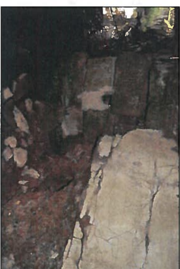
Rozpad zdi a ponučty opěry na pravoběžném voku
