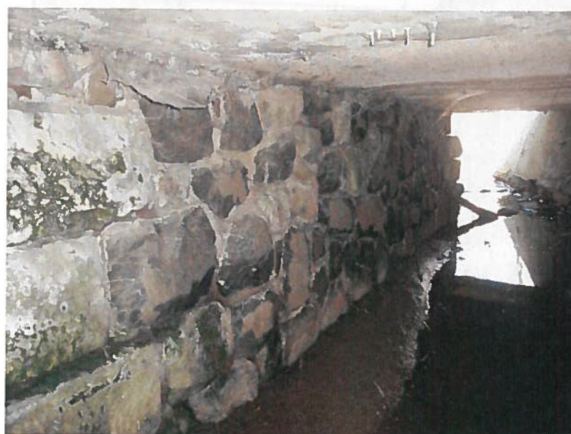
Most ev. č. 28615-2, most přes potok v Roztokách u Jilemnice
