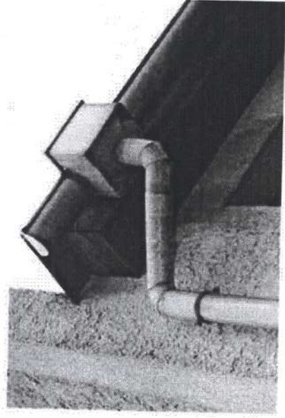
Stav bednění podhledu na jihu západním rohu
