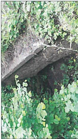
Pohled na levou stranu konstrukce
