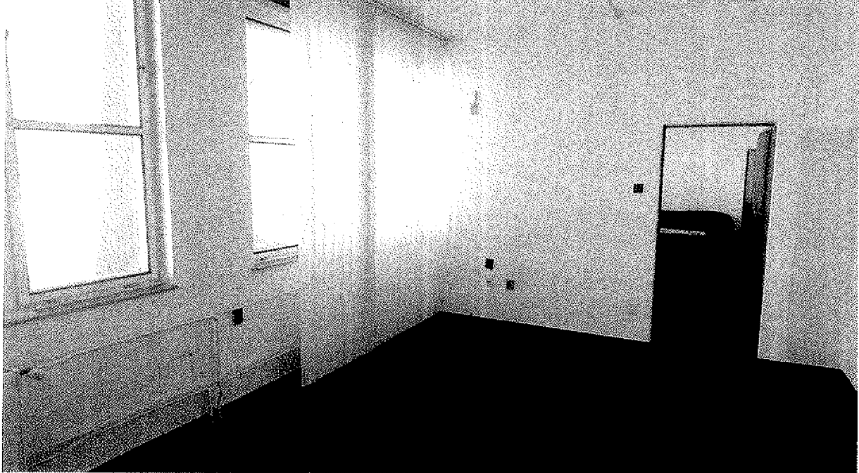
Obr. 2 – pohled na stávající umístění datových zásuvek, podlahový žlab je v linii s obvodovou stěnou pod datovou zásuvkou
