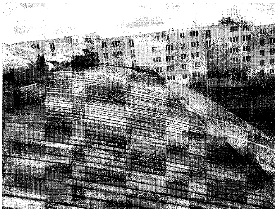
Foto č. 1 – celkový pohled na odtrženou střešní krytinu nad blokem A
