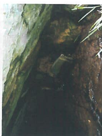
Most ev. č. 2781.4-2 přes potok na Záštalí
