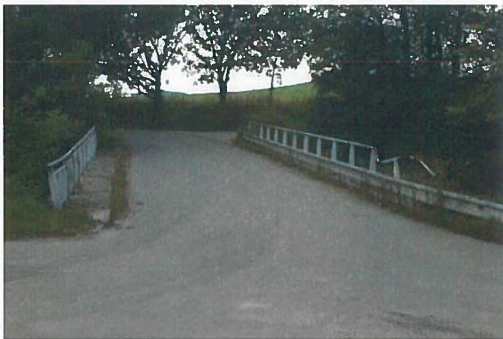
Pohled proti staničení
