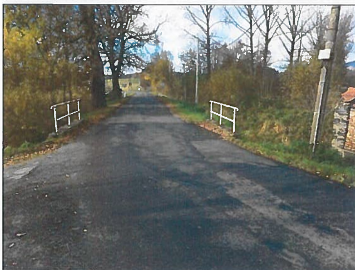
Celkový pohled proti směru staničení
