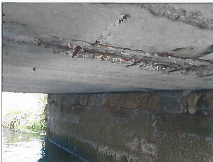
Podhled NK pole1
