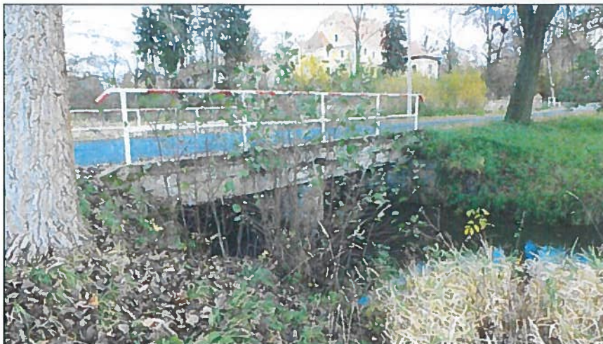
Pohled na pravou stranu konstrukce
