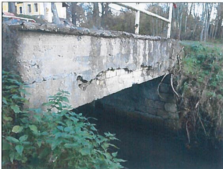
Pohled na pravou stranu konstrukce
