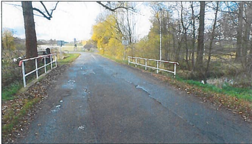
Celkový pohled proti směru staničení
