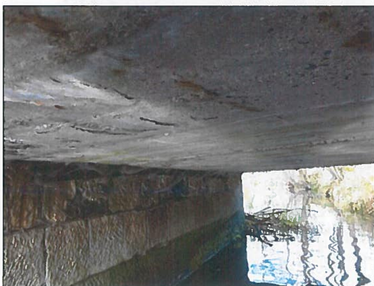
Podhled NK pole2
