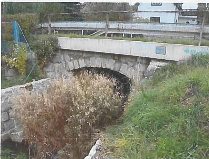
Pravá výtoková strana mostu
