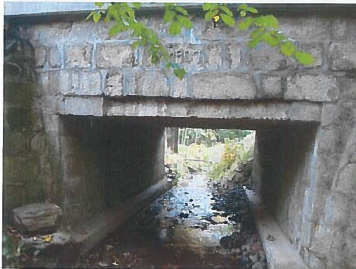
Levá vtoková strana mostu
