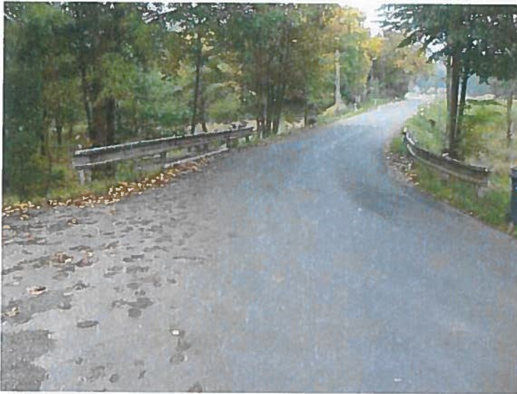
Pohled po směru staničení
