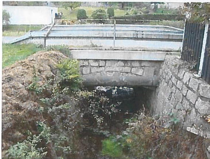
Levá vtoková strana mostu
