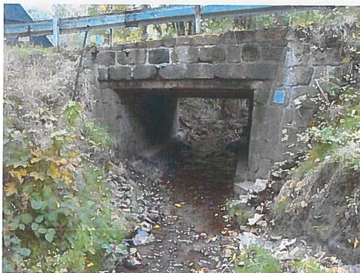
Pravá výtoková stran mostu
