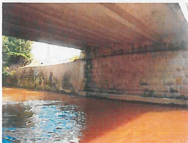
Most ev. č. 27915-2, Přepeře přes náhon
