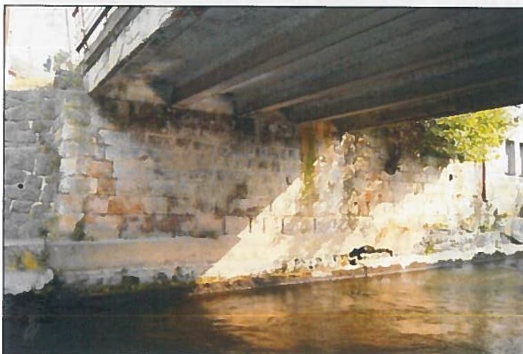
Pohled na lic pravobřežní opěry a podhled NK
