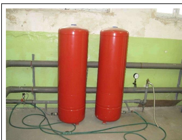
Expandéry EXPANZOMAT B a potrubní systémy kotelny
