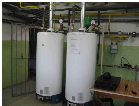
Zásobníkové ohřivače vody QUANTUM Q7 75 NRRS-E s kontrolními prvky a expanzomatem
