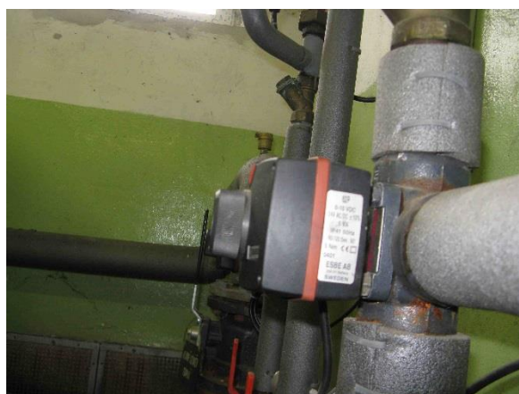
Trojcestný ventil a servomotor ESBE
