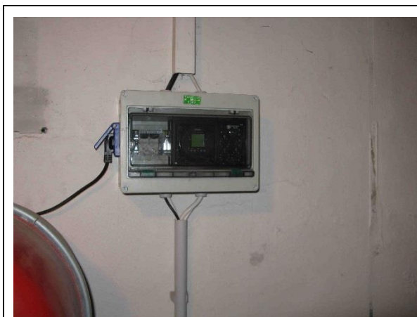
Regulátor vytápění KOMEX THERM PA 5
