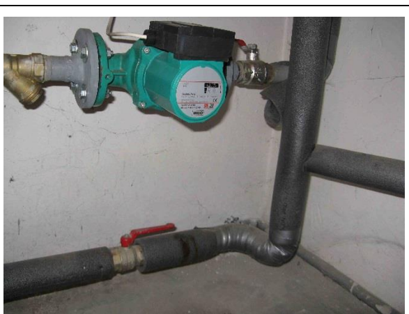
Oběhové čerpadlo TV WILO TOP Z 40/7 RG
