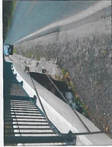
soukromý archiv autora - 2013 - propad na obou koncích desky vpravo
