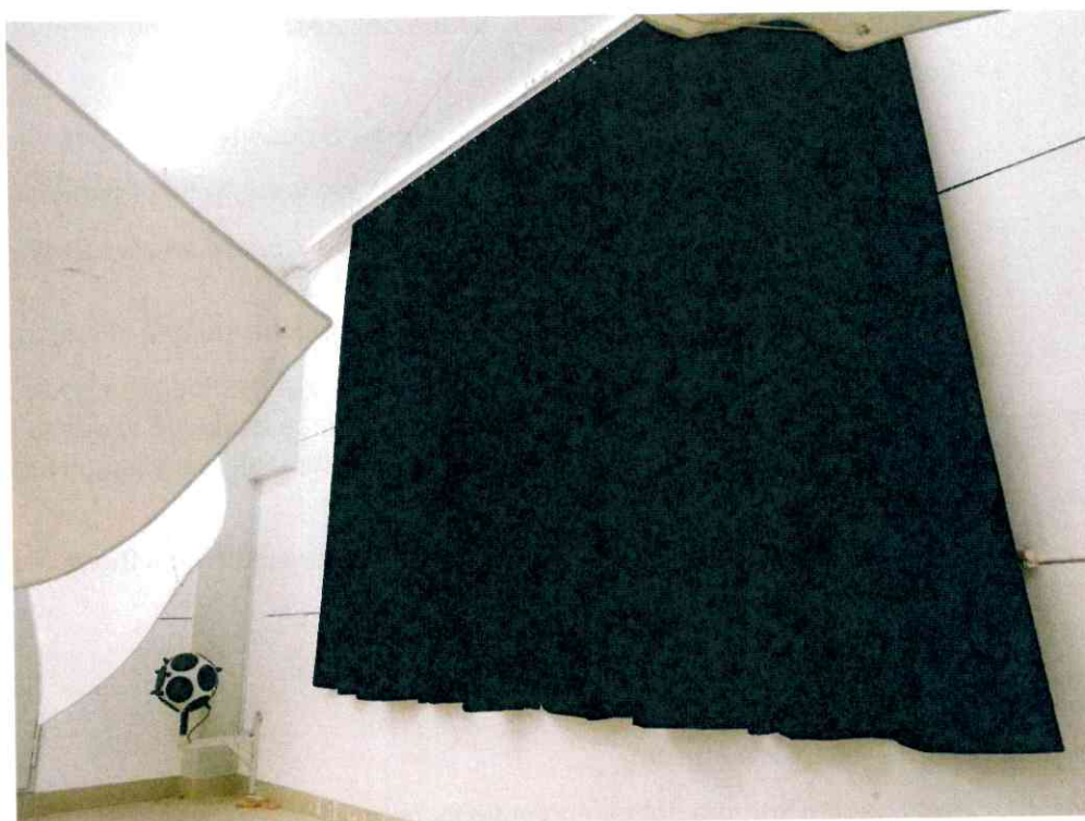
Obrázek B.2. Záclona v dozvukové místnosti, zavěšená v řase.
