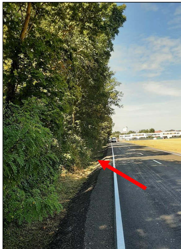
Obr.6: Položka 1009 (SO 103) – větve stromového patra a keřové patro ovlivňující rozhledové poměry, navržený prořez větví a smýcení keřů.
