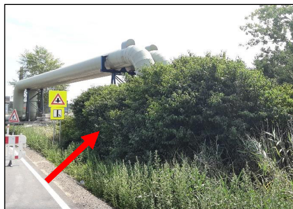
Obr.8: Položka č. 1011 (SO 101) – keřový porost v místě křižovatky, ovlivňující rozhledové poměry, navržený na kácení.
