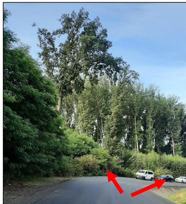
Obr.4: Položka 1006 (SO 105) – větve stromového patra a keřové patro ovlivňující rozhledové poměry v zatáčkách, navržený prořez větví a smýcení keřů.
