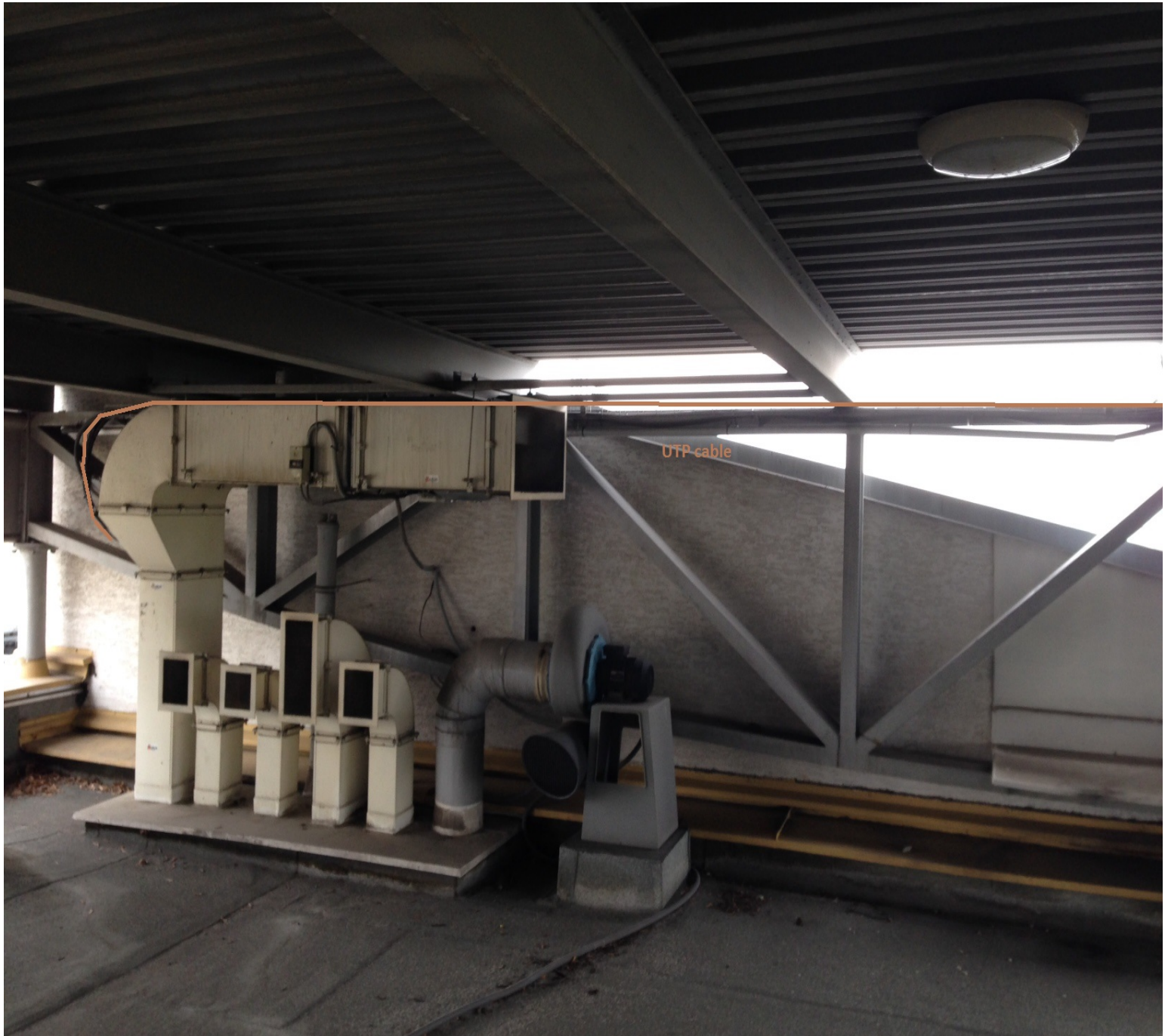
Vedení UTP kabelu stávajícími kabelovými rošty.
