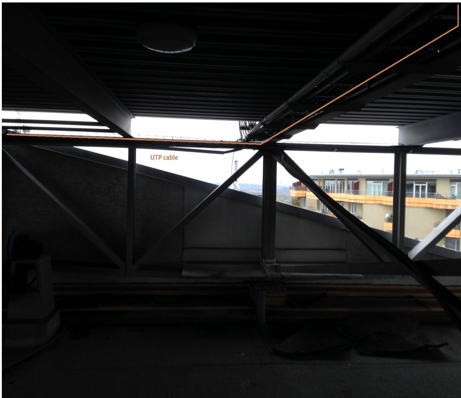
Vedení UTP kabelu stávajícími kabelovými rošty.
