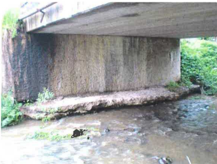
Podemletá pata opěry
