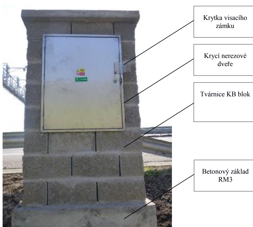
Obrázek 1: Příklad provedení stavby obvyklé pro rozvaděč RM3 použité pro MX/SX typ 1
