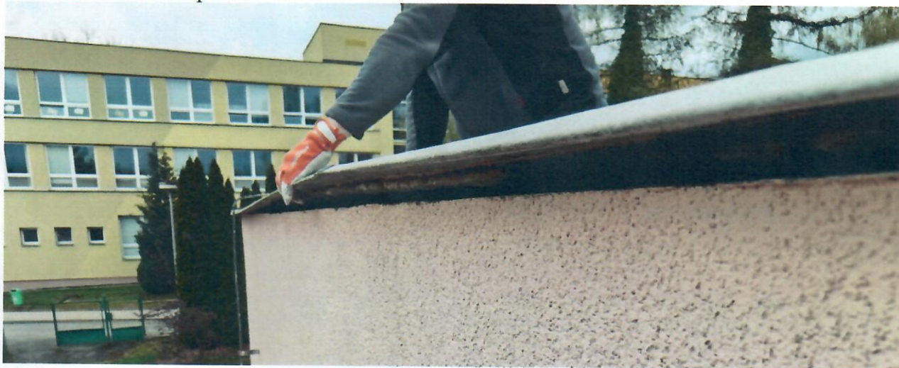
Nekvalitně provedené opravy podšaty světlovodu
