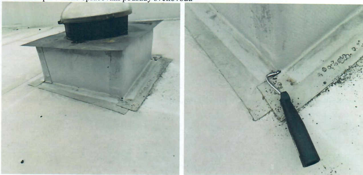
Nekvalitně provedené opravy podšaty světlovodu
