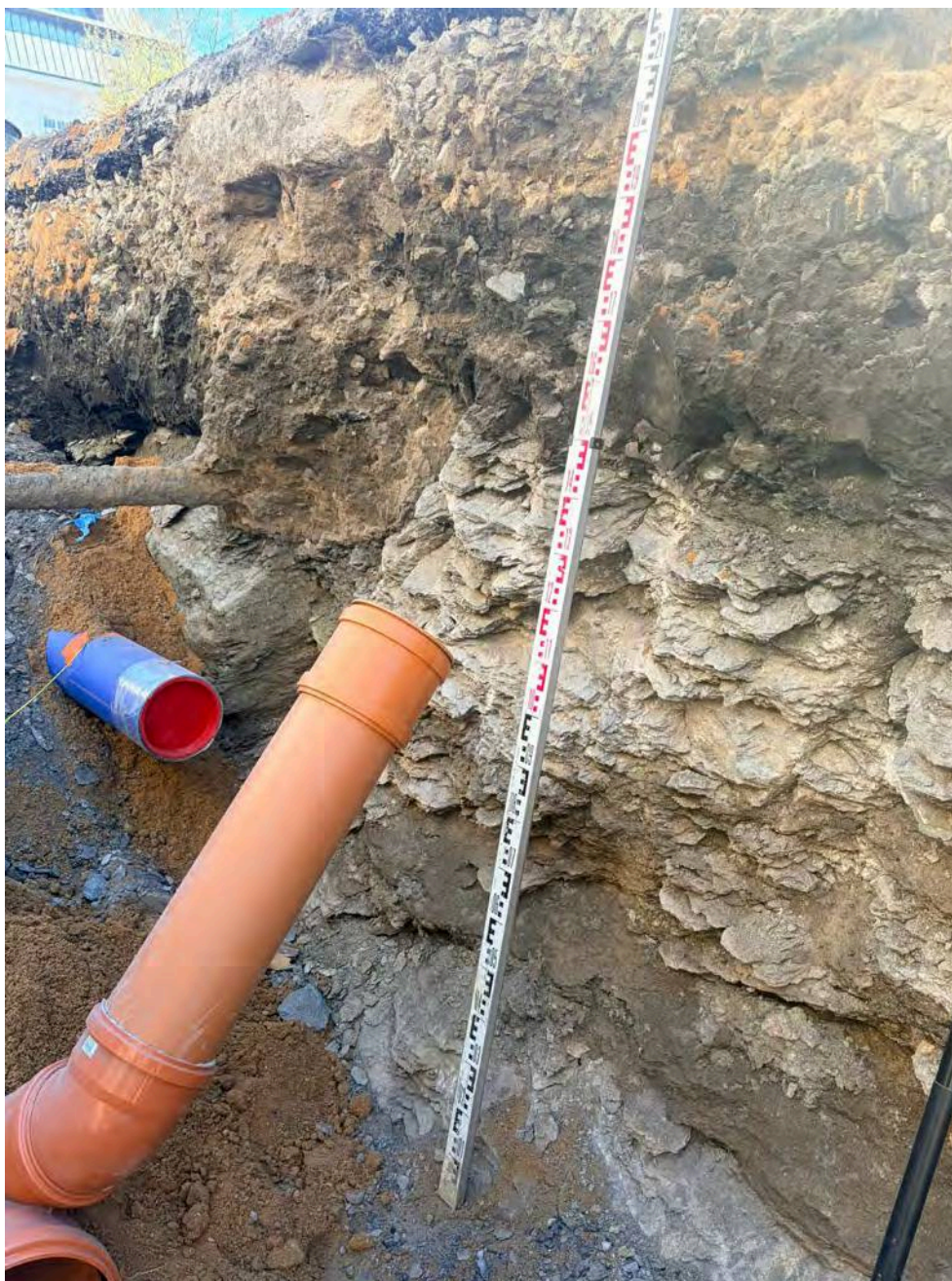
Obrázek 10. Fotografie výkopu 10 m za ŠK5.
