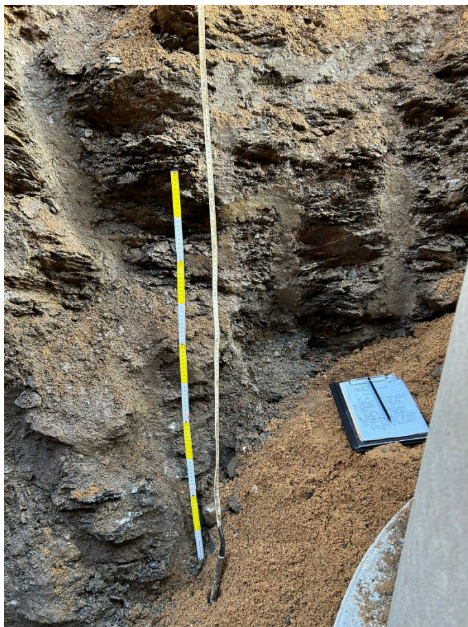
Obrázek 4. Spodní část výkopu u ŠK2.
