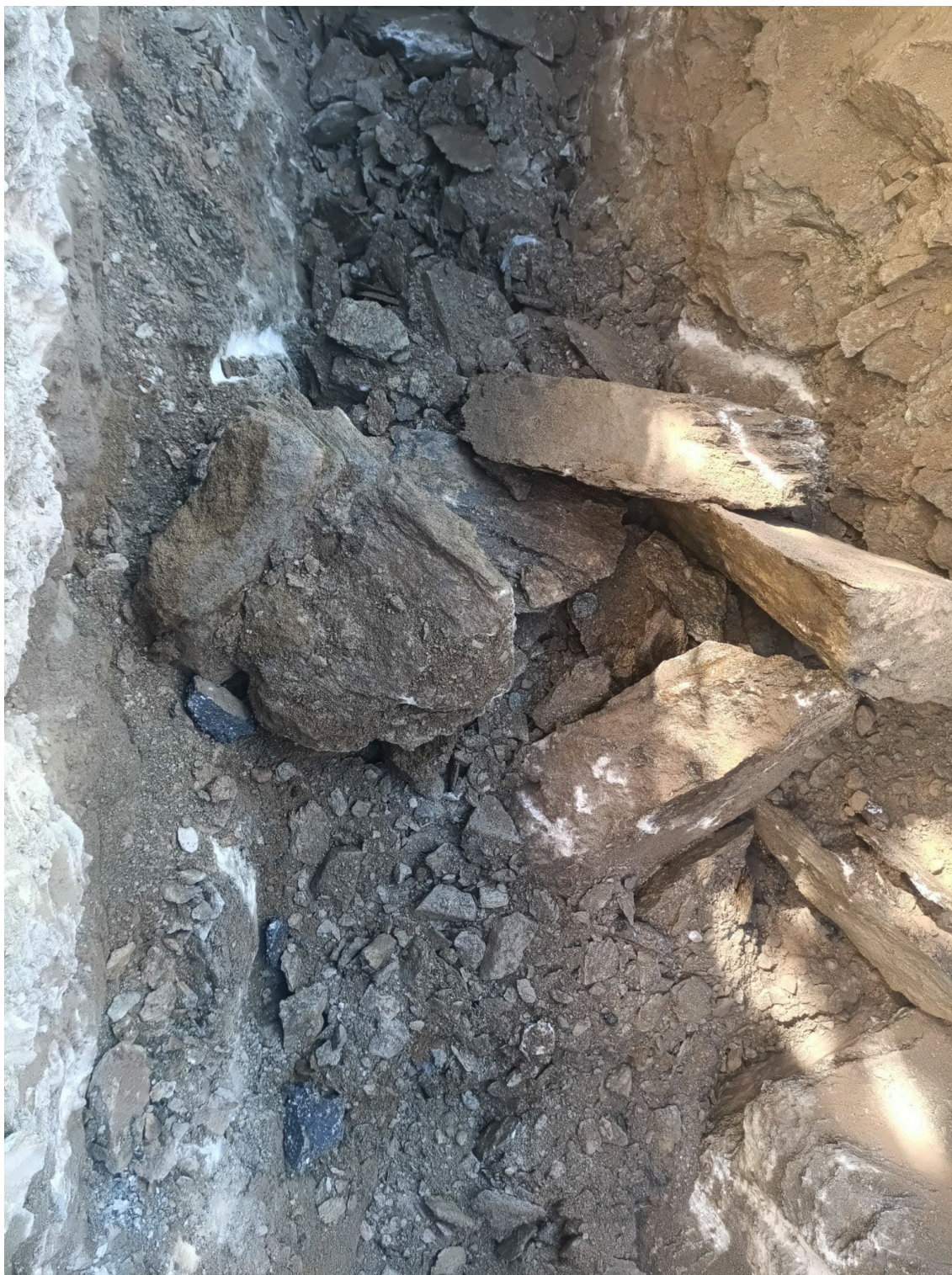
Obrázek 8. Pohled na dno výkopu – poloha viz foto 7. Foto stavba. 14. 3. 2026.
