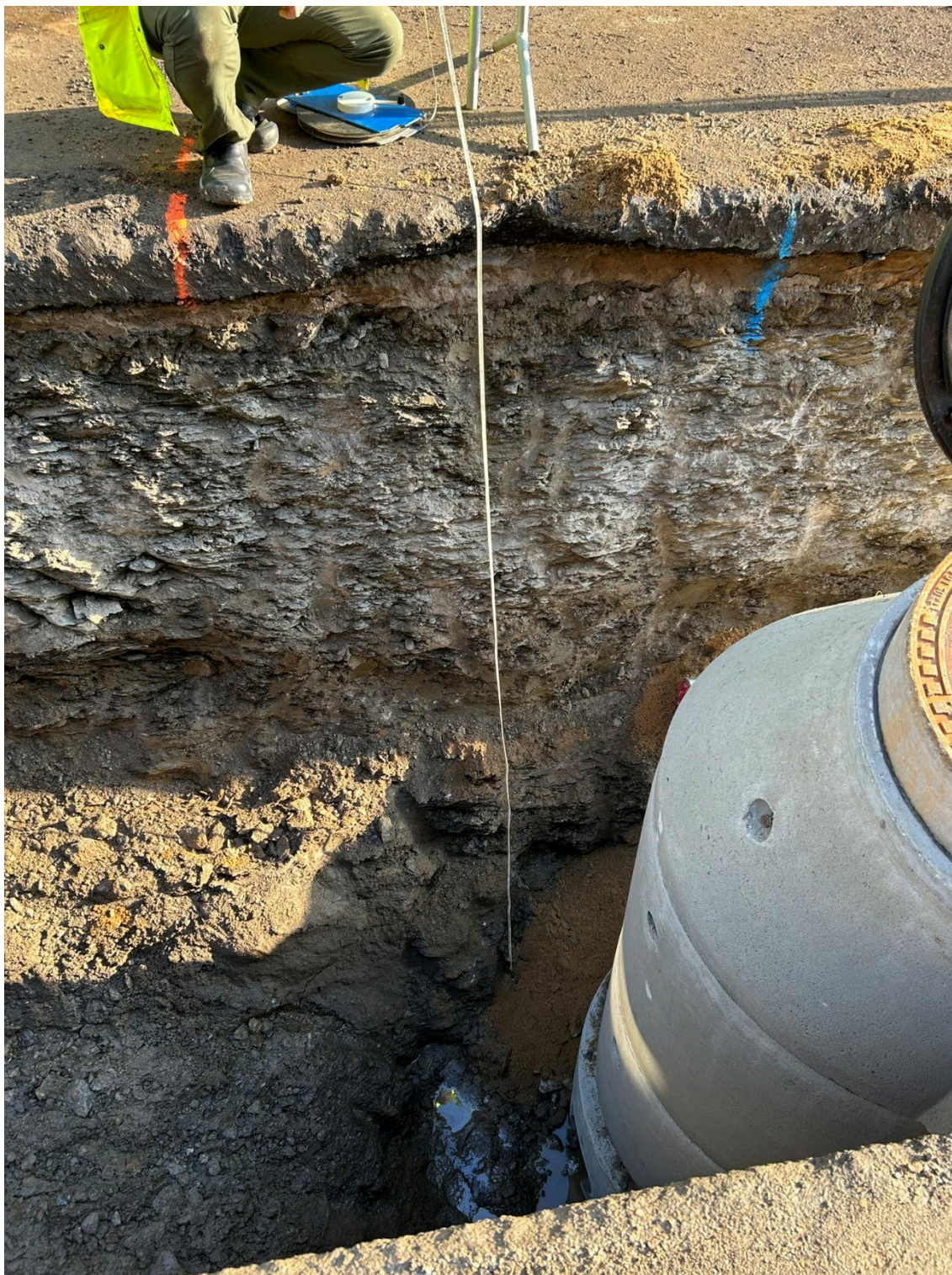
Obrázek 2. Celkový pohled na profil výkopu u ŠK2.
