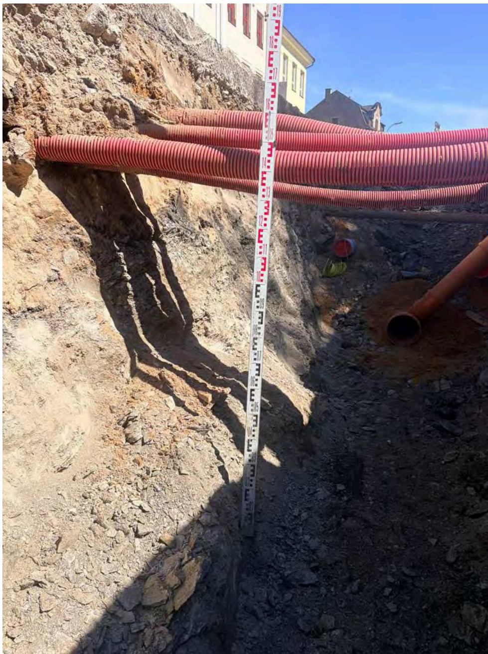
Obrázek 11. Fotografie výkopu 10 m za ŠK5.
