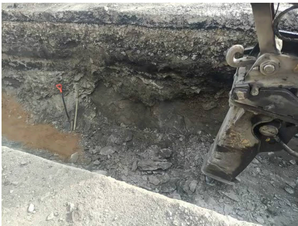
Obrázek 9. Fotografie výkopu 5 m za ŠK5.
