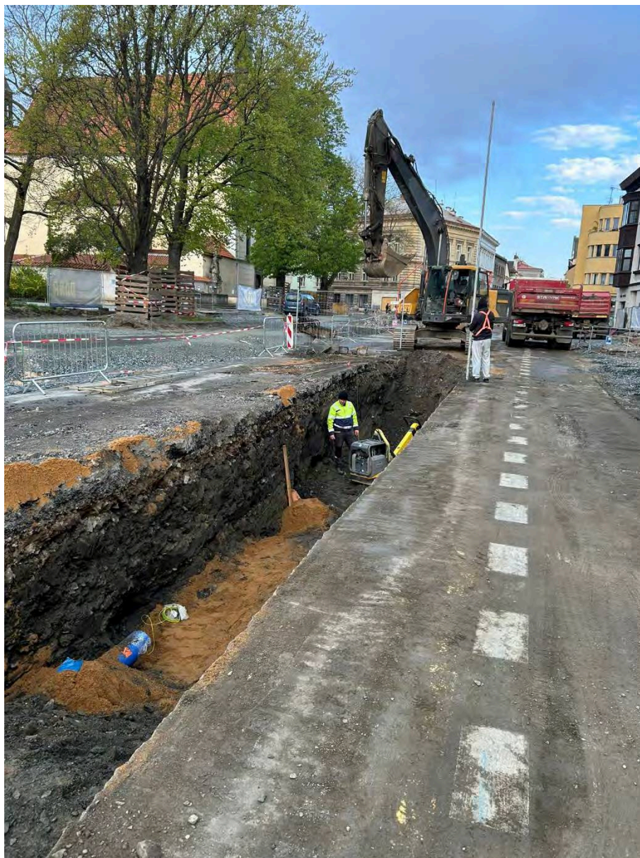
Obrázek 1. Celkový pohled na dokumentovaný výkop před parkem, jižní strana výkopu.
