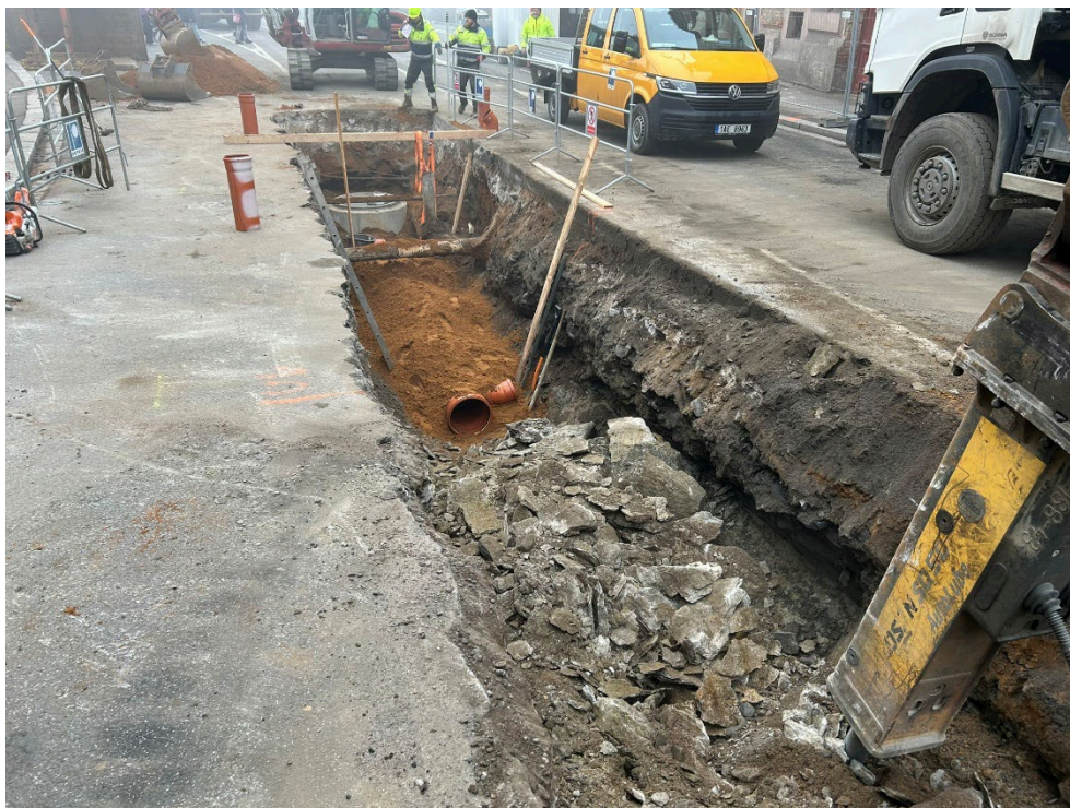
Obrázek 2. Celkový pohled na dokumentovaný výkop od ŠK2 (při spodní straně obrázku) k ŠK1.
