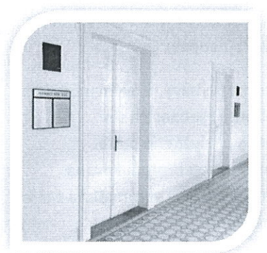
Příklad výbavy předsálí jednací síně reproduktorem v provedení instalace pod omítku. Pod reproduktorem je umístěna tabule informačního systému označující vstup do JS.
