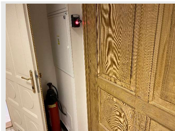
21: Nouzové odpojení elektřiny každé laboratoře
