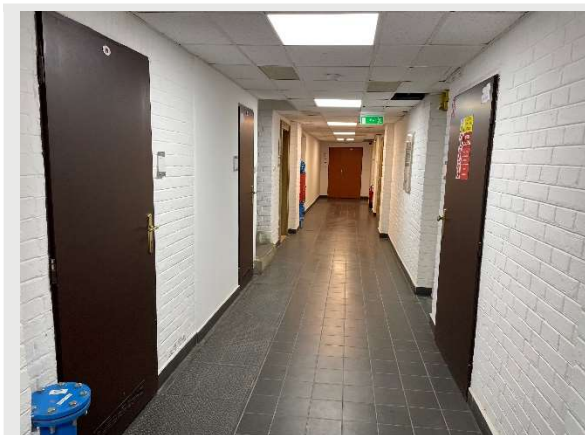
14: Chodba v budově A
