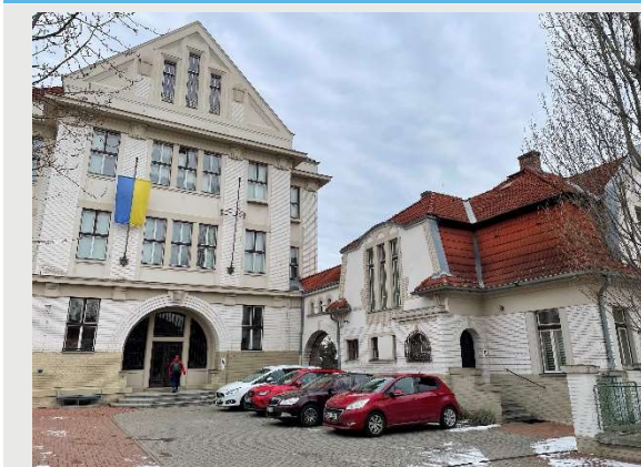
13: Hlavní budova A (vlevo), budova B
