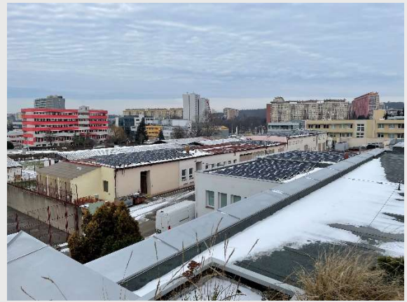
8: Fotovoltaické elektrárny Na Slovance
