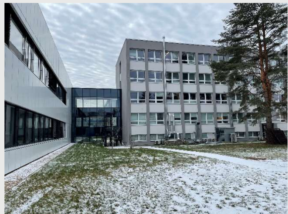
12: SOLID21 (vlevo), hlavní budova
