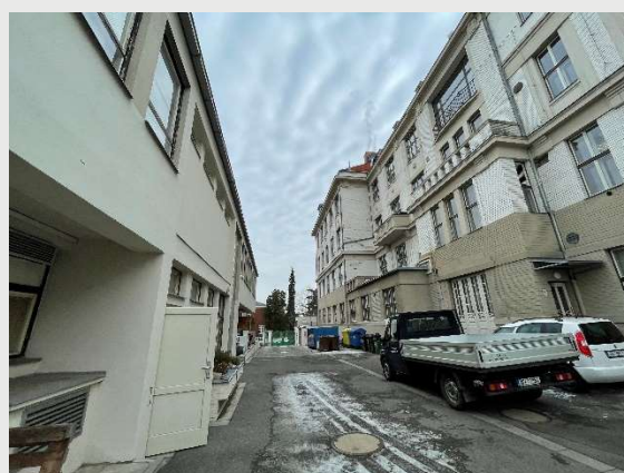
13: Budova F (vlevo), budova A
