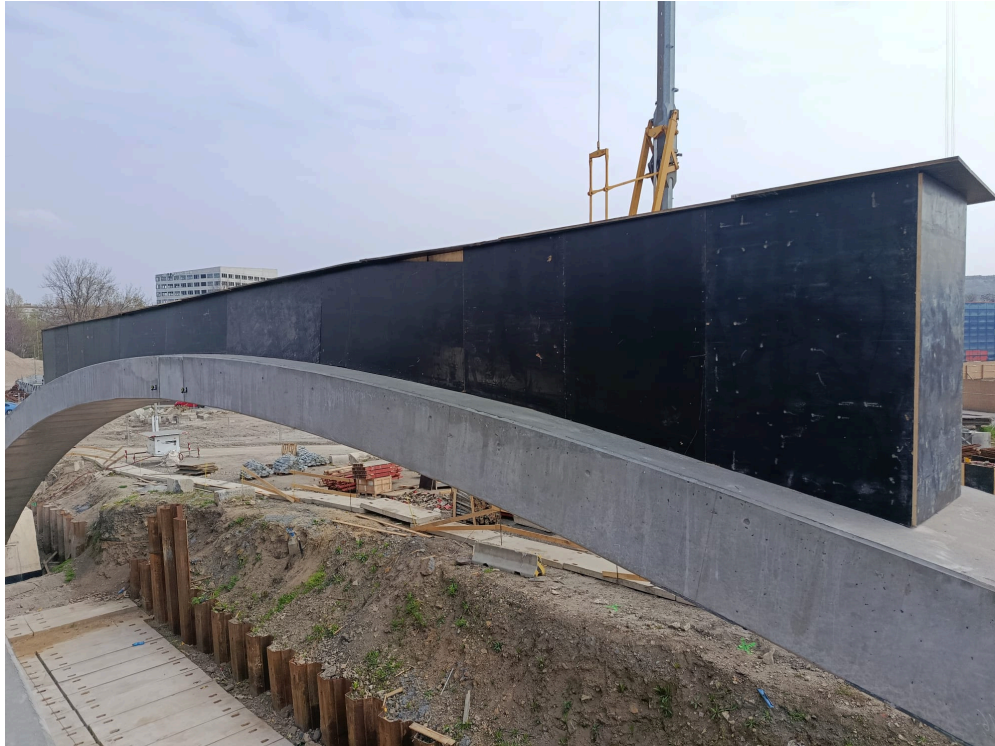
Foto 03 – zakrytí výztuže vrcholů oblouků
