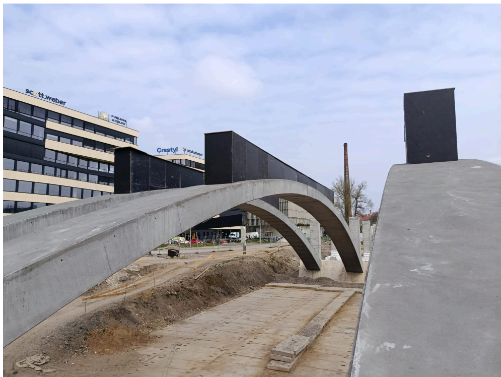
Foto 02 – zakrytí výztuže vrcholů oblouků
