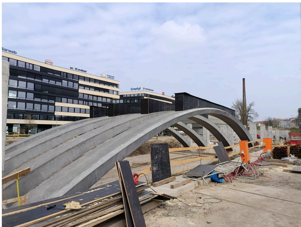
Foto 01 – zakrytí výztuže vrcholů oblouků
