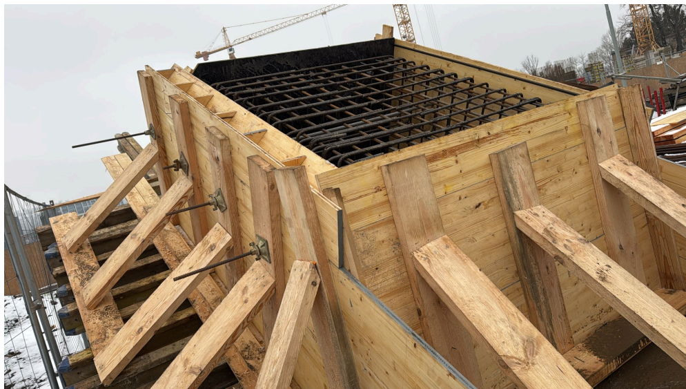
Foto 01 – doplňkový zkušební blok – výztuž
