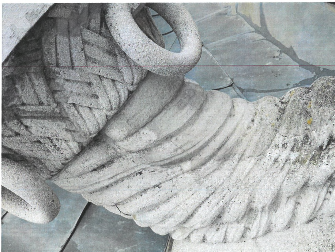
Obrázek 6: Detail rohu hojnosti s dožilým tmelem a řadou mikro trhlin.
