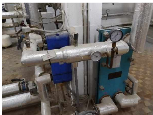
deskový výměník pro TV (horkovod/teplá voda)
