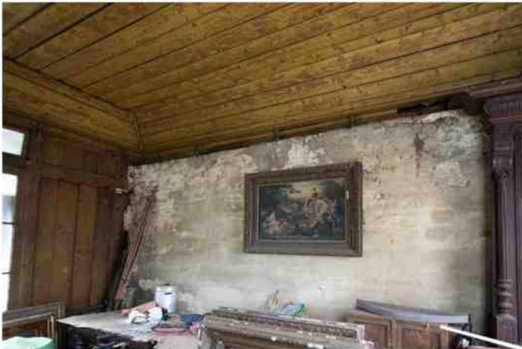
Pohled – interiér se zadní cihlovou stěnou
