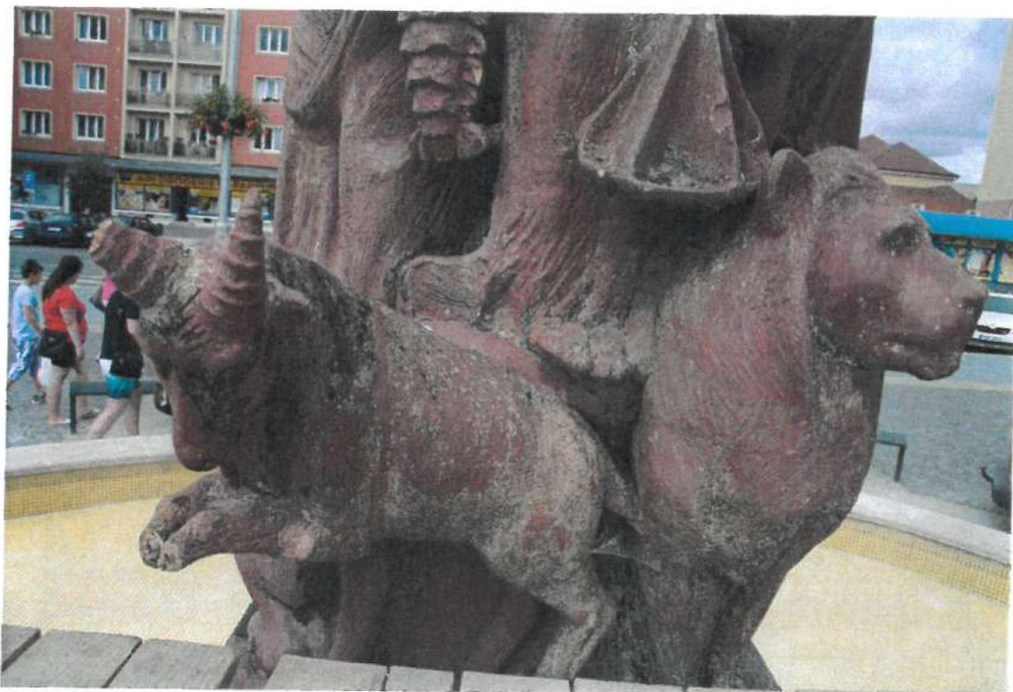
Detail stavu poškození sousoší fontány.
