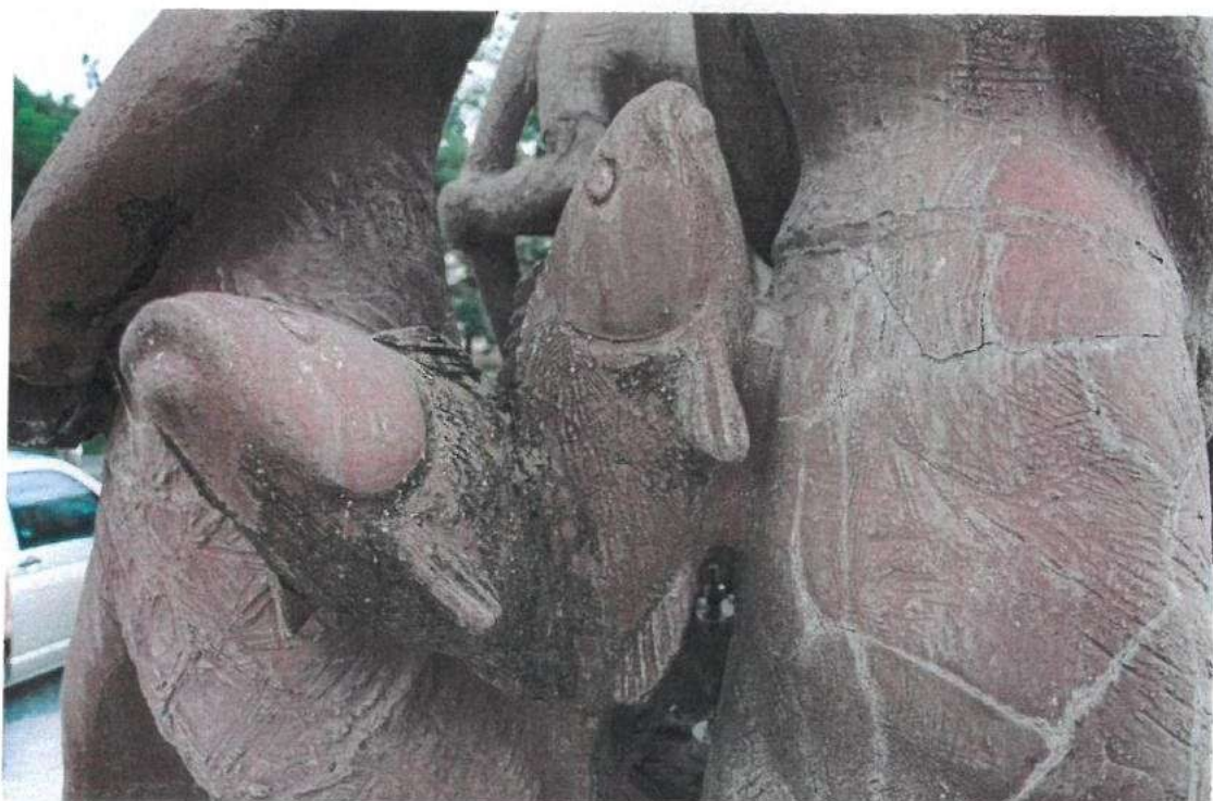
Detail poškození terakoty sousoší fontány „Ryb“ a „Blíženců“.
