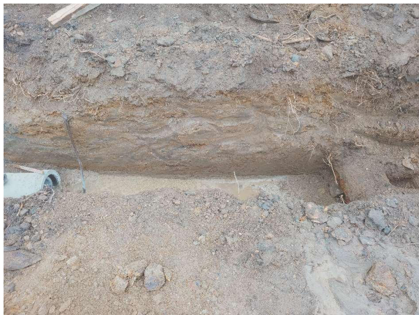
Foto č.2 – nové potrubí (vlevo) a stávající vodovodní řad (vpravo)
