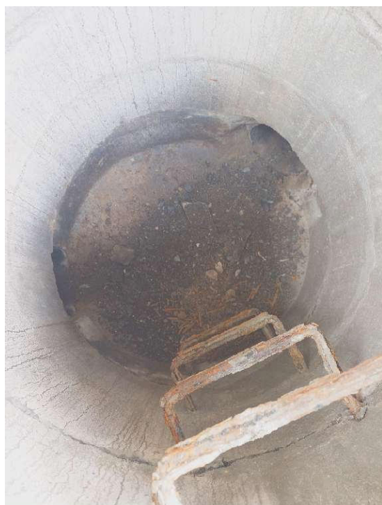
Foto č.2 – vnitřek šachty
