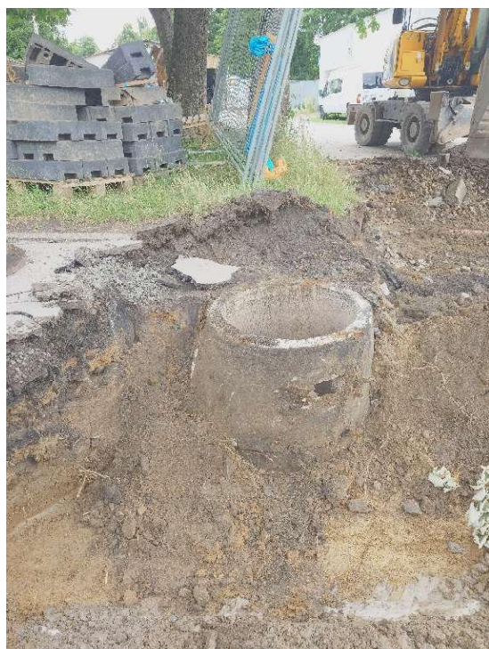
Foto č.1 – umístění stávající šachty v původním chodníku
