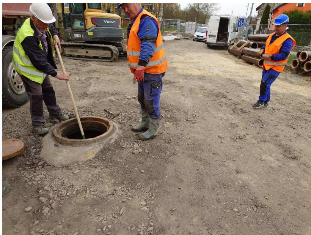
Foto č.1 – umístění stávající šachty v původním kruhovém objezdu
