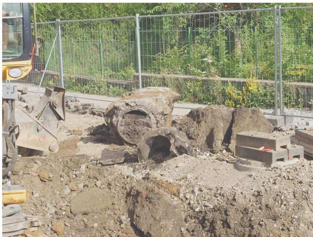
Foto č.4 – vybourané zanesené potrubí
